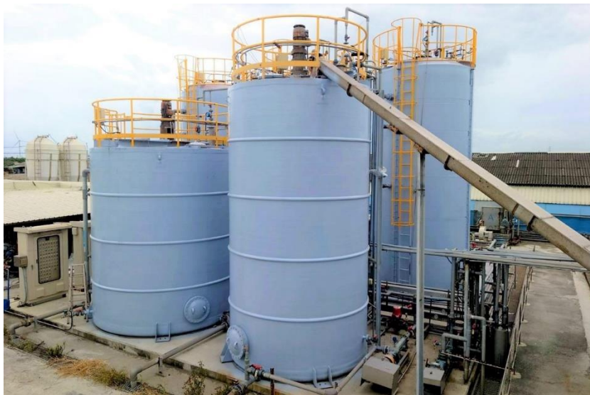
圖 3-7 可阻擋 90%的太陽熱能進入儲槽
