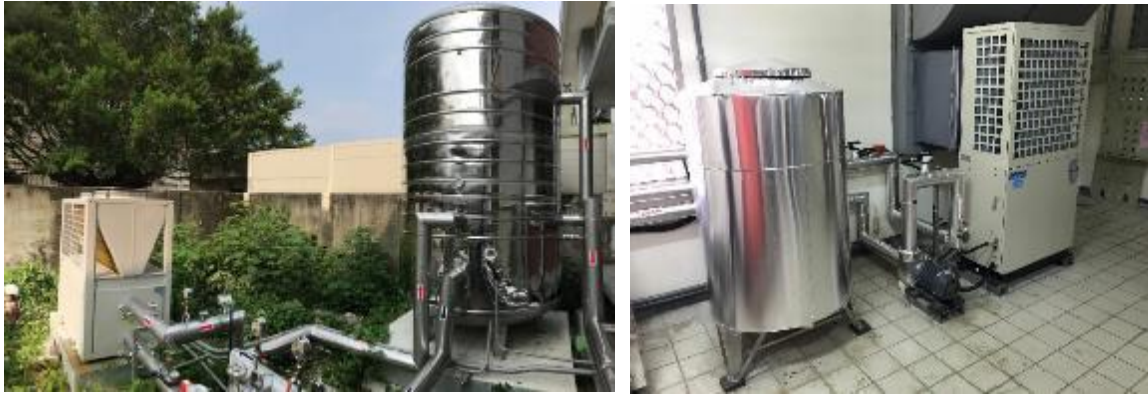
圖 3-11 空氣源熱泵系統
