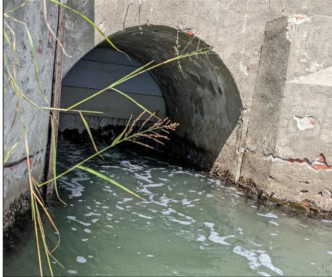
圖 58 B30 水閘門木製擋板漏水情形
