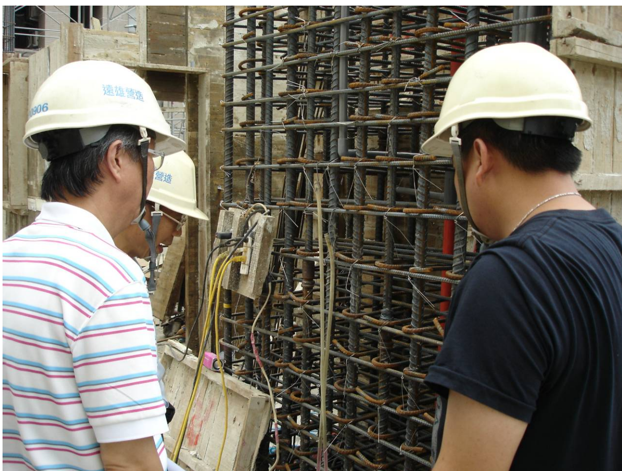
圖 2-7 現場工地鋼筋施工
