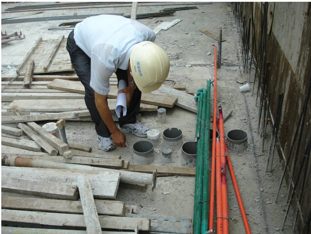
圖 2-8 浴室防水施工處理
