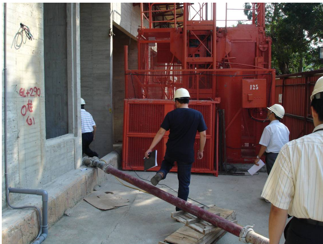
圖 2-5 新建住宅性能評估制度-建造性能-遠雄建設(續)
