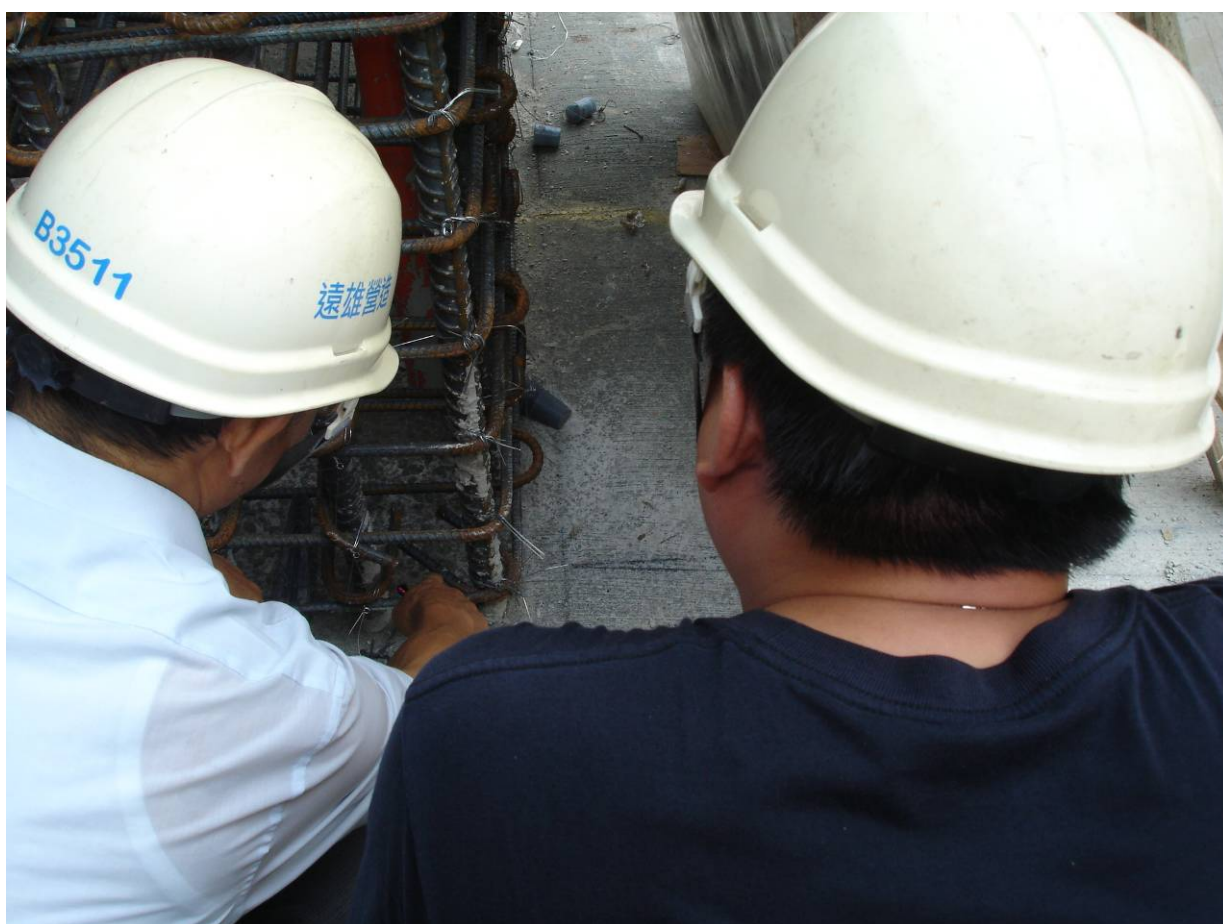
圖 2-9 工地現場柱子箍筋施工
