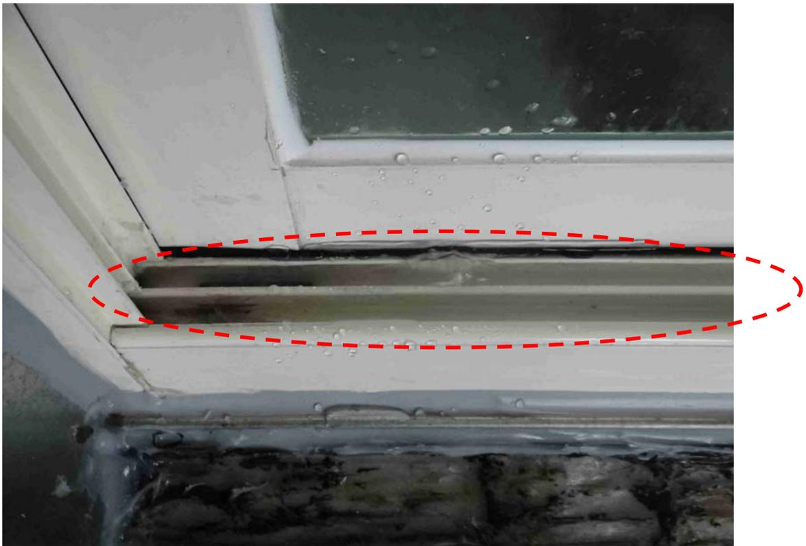
圖4-26 過量的水由排水洞經排水器冒上來，造成溝槽滿溢
