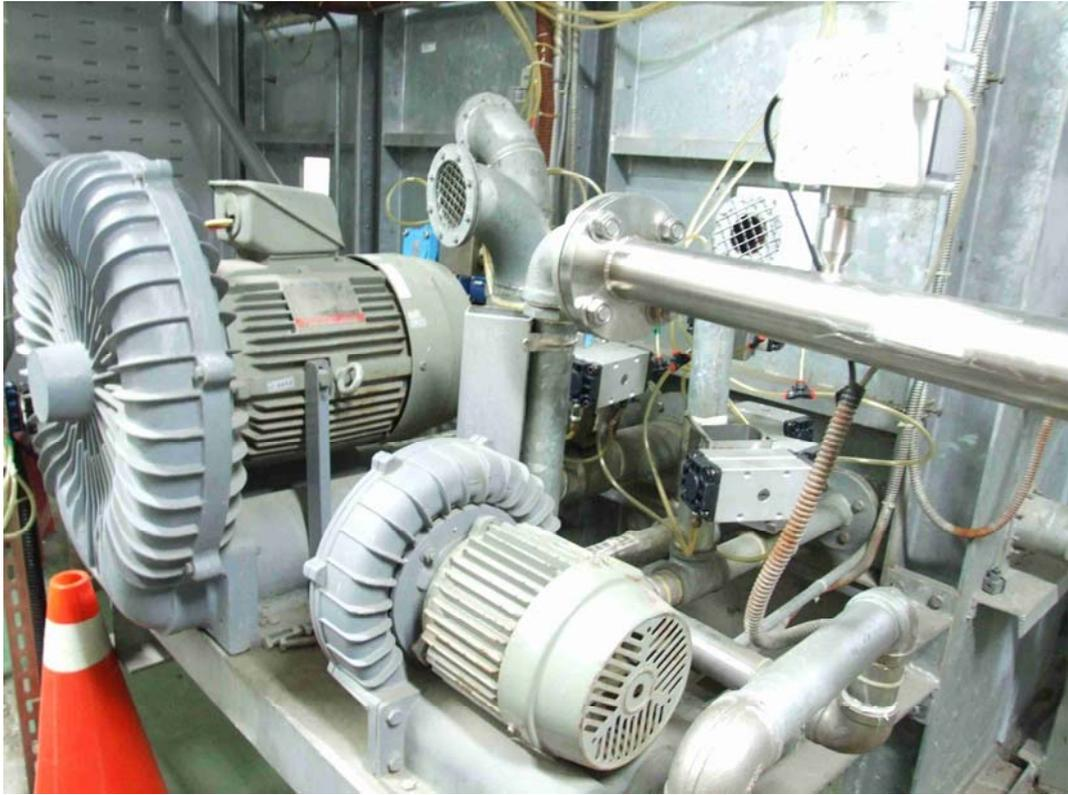
圖4-4 測試艙加壓之鼓風機組
