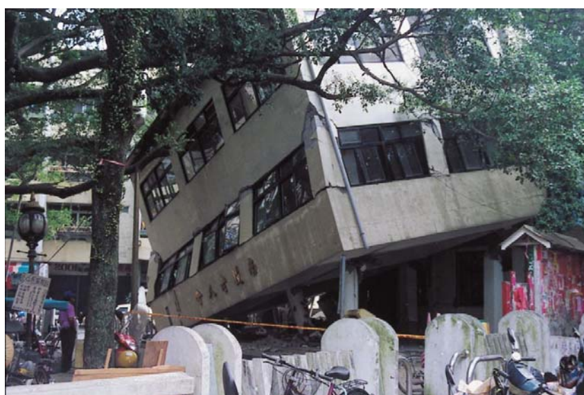
圖 1-2 921 地震老人會一層挑空軟弱層，整體壓毀傾倒 (資料來源：本研究)
