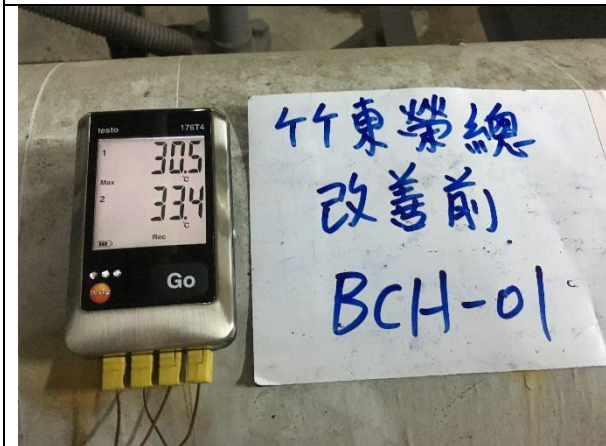
項目：改善前 冰水主機溫度量測
