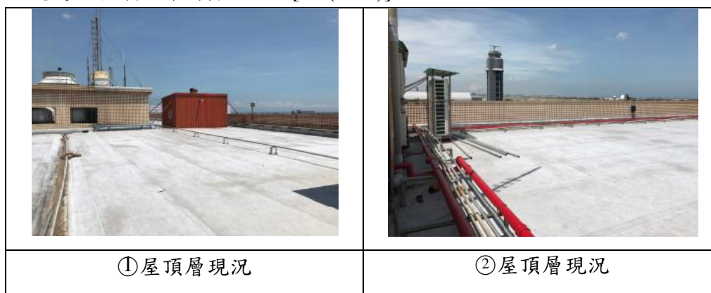
圖 9.6 屋頂現況照片
