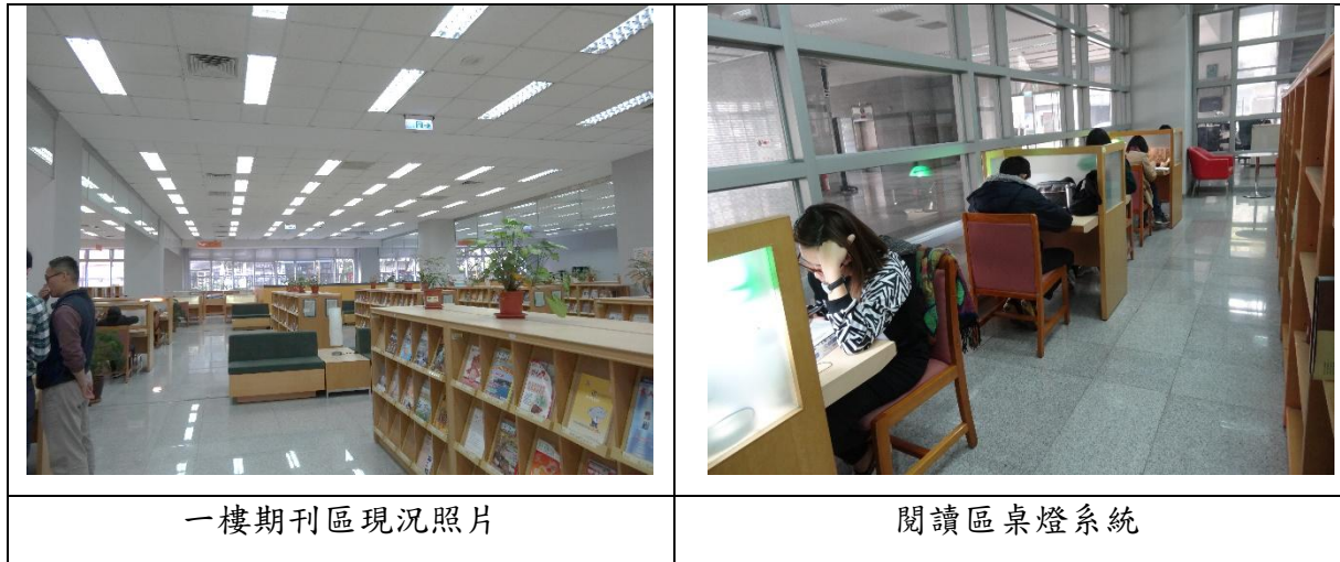
圖 3.4 圖書館照明現況照片
