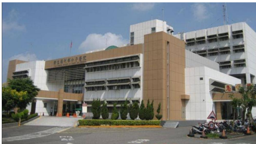
圖 6.6 衛生福利部朴子醫院 建築物外觀
