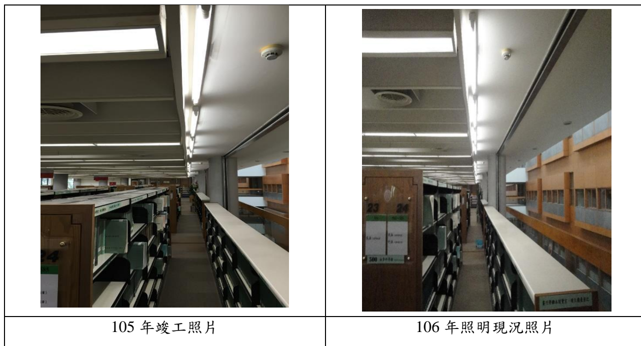
圖 6.16 105 及 106 年度照明改善追蹤照片
