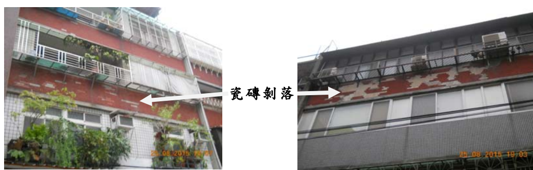
圖 1-1 國內公寓大廈外牆瓷磚剝落
