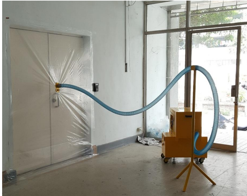
圖 2.7-4 現場遮煙設備實際配置情況
