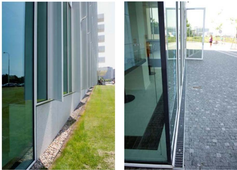
圖 4-36 西向立面遮陽板與敷地透水設計及雨水截水溝<sup>[19]</sup>
