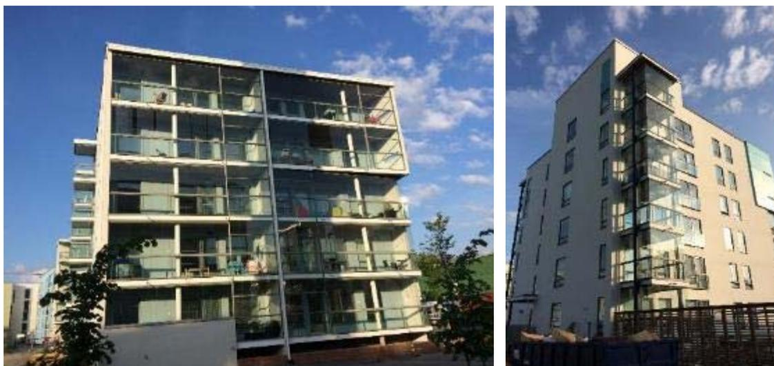
**圖 4-23 Härmälänranta 永續住宅個案高反射外牆及導入南向日照**
