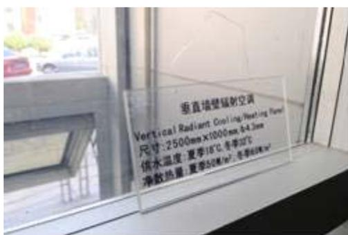
圖 4-42 節能研究中心垂直壁面輻射空調 [21]
