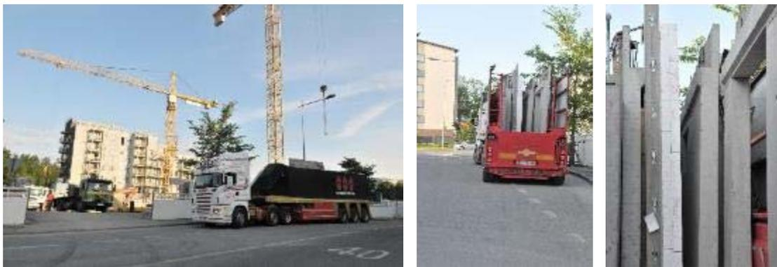
**圖 4-28 Härmälänranta 永續住宅採預鑄式開放建築工法施作**
