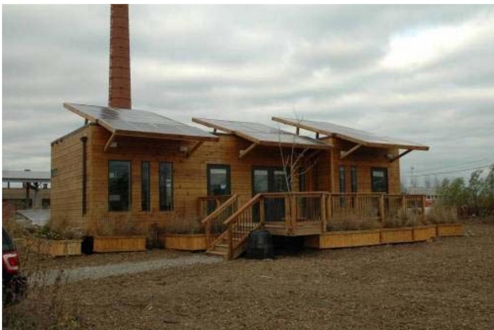
**圖 4-8 與伊利諾大學共同建立的太陽光電發電與木構造實驗屋**
