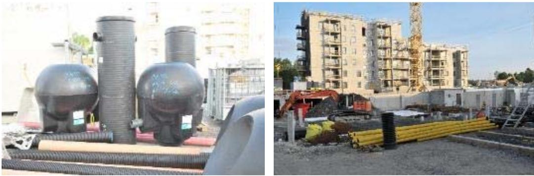
**圖 4-27 Härmälänranta 永續住宅開發區雨水排水、滲透及貯留設施**
