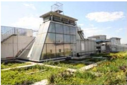
圖 4-48 節能研究中心浮力通風換氣井頂部<sup>[21]</sup>
