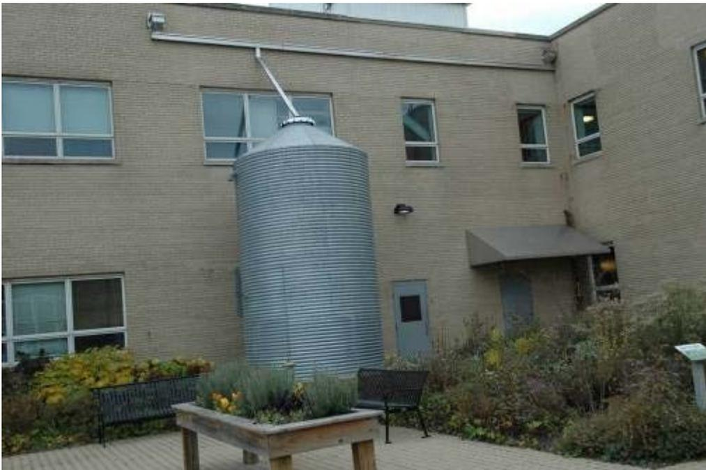
**圖 4-5 芝加哥綠色科技中心雨水收集貯留槽**
