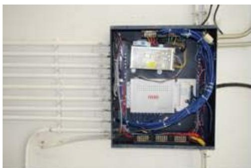
圖 4-44 節能研究中心天花板面輻射空調控制器 [21]
