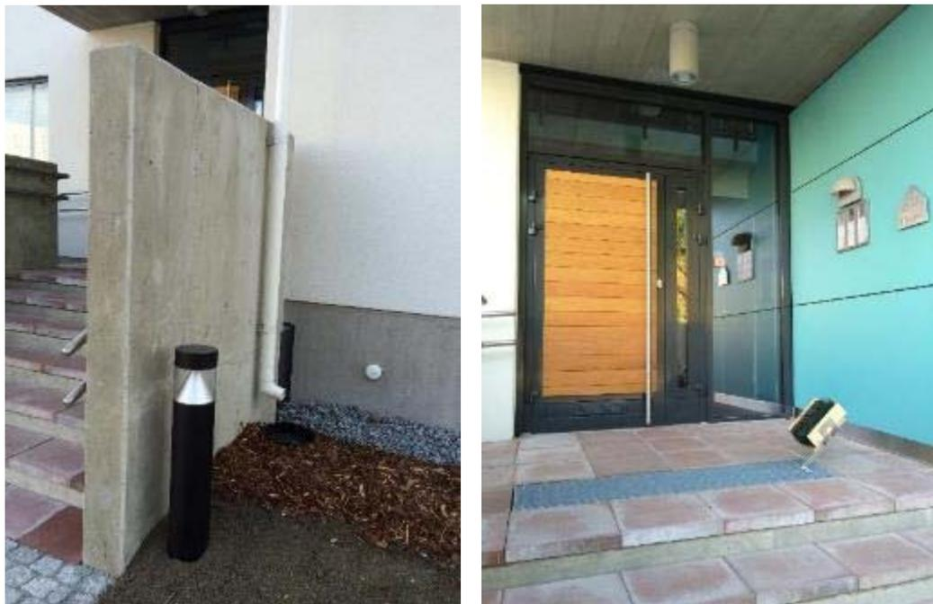
**圖 4-24 Härmälänranta 住宅雨水排水管及玄關過篩導水格柵**
