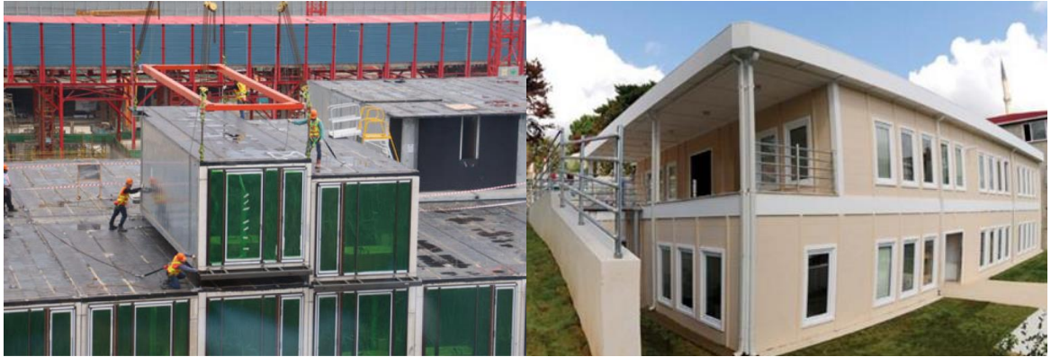
圖 3-33、預製體積建設 PPVC 示意圖
