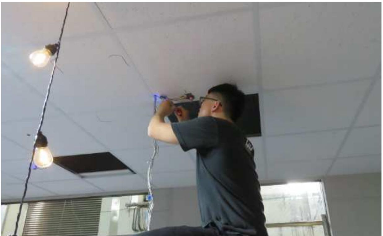
圖 3-31 感測模組更換與測試
