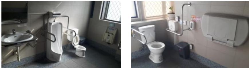
圖 4-124 不分性別廁所內部(本研究整理)
