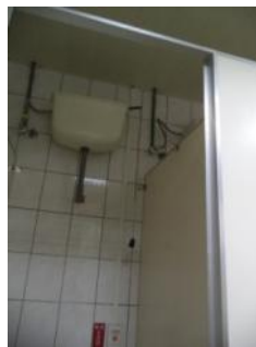
圖 4-7 大便器廁間隔板上部空隙 (本研究整理)
