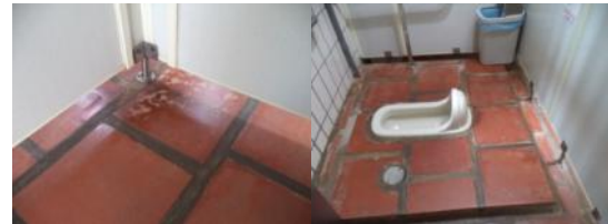
圖 4-71 廁間隔板下部空隙 (本研究整理)
