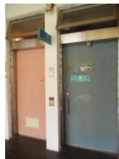
圖 4-132 廁所入口(本研究整理)
