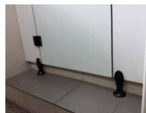
圖 4-34 大便器廁間隔板下部空隙 (本研究整理)
