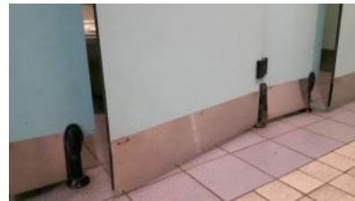
圖 4-77 大便器廁間隔板下部空隙 (本研究整理)
