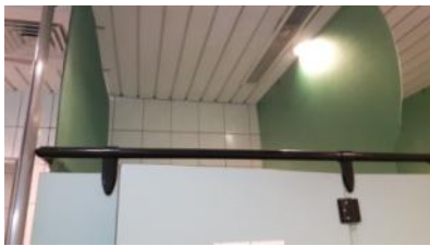
圖 4-76 大便器廁間隔板上部空隙 (本研究整理)
