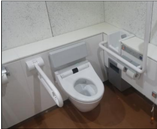
圖 4-178 日本不分性別無障礙廁所設施(日本埼玉 日本工業大學) (本研究整理)
