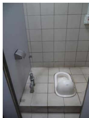
圖 4-12 大便器廁間隔板下部空隙 (本研究整理)
