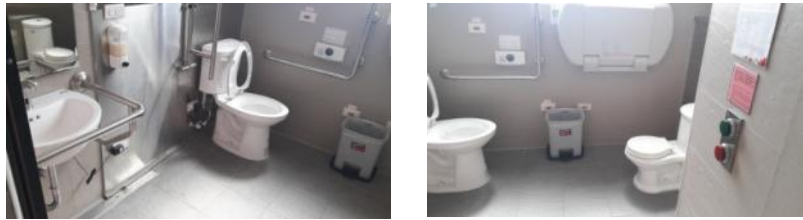
圖 4-115 不分性別廁所內部(本研究整理)
