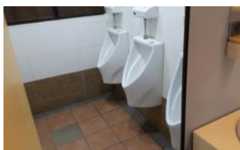
圖 4-59 小便器隔間 (本研究整理)
