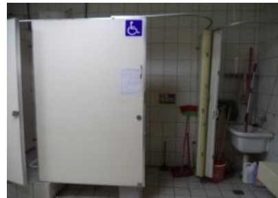
圖 4-6 無障礙廁所(本研究整理)
