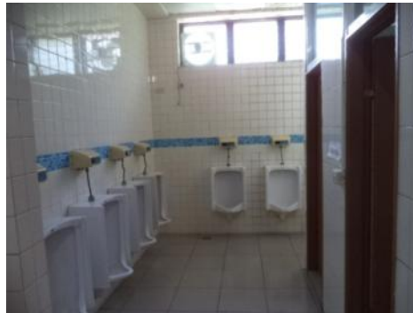
圖 4-143 不分性別廁所內部 (本研究整理)
