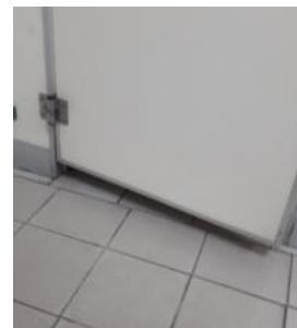
圖 4-8 大便器廁間隔板下部空隙 (本研究整理)
