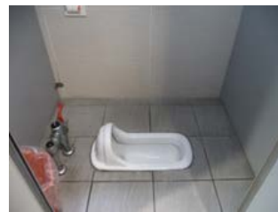
圖 4-29 大便器廁間隔板下部空隙 (本研究整理)
