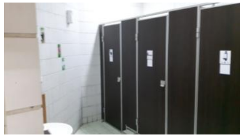
圖 4-43 不分性別廁所廁間 (本研究整理)
