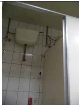
5. 通用無性別廁所大便器隔板上部空隙
