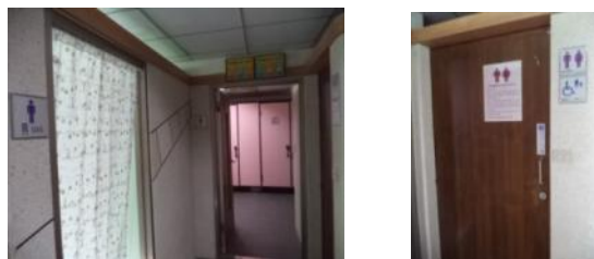
圖 4-128 不分性別廁所入口(本研究整理)
