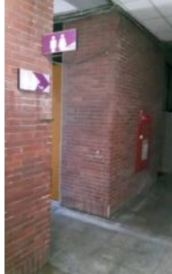
圖 4-152 廁所入口 (本研究整理)
