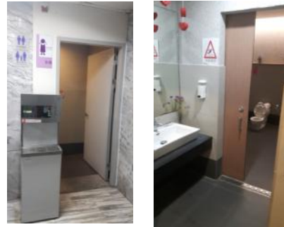
圖 4-89 不分性別廁所入口(本研究整理)
