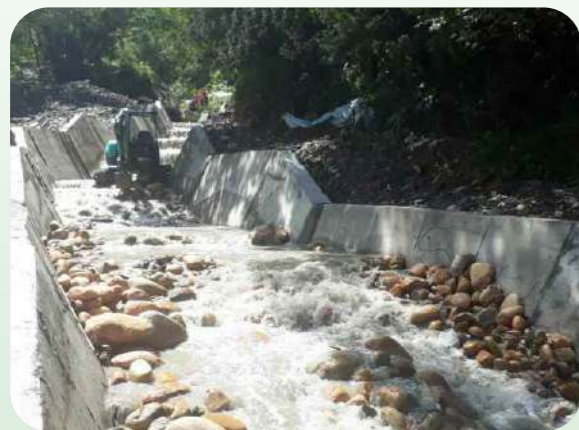
▲ 圖 4-5 機場捷運A7站地區區段徵收公共工程第六標-蝕溝編號6完工照片
