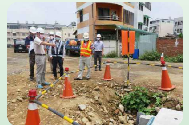
▲ 圖 4-41 「南投縣藍田市地重劃工程」施工督導情形
