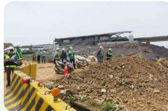
▲ 圖 4-38 「桃園機場捷運A20站區區段徵收工程(基本設施)」施工督導情形
