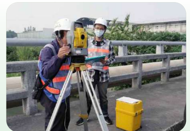
▲ 圖 4-31 現場樁位測定實況(二)
