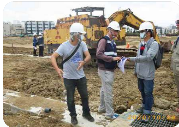
▲ 圖 4-45 「澎湖縣四維路以北區段徵收道路及公共設施新建工程（公五公六地區）」施工督導情形
