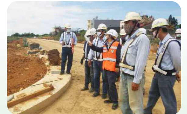
▲ 圖 4-39 「桃園市觀音區草漯第三區整體開發單元市地重劃統包工程」施工督導情形
