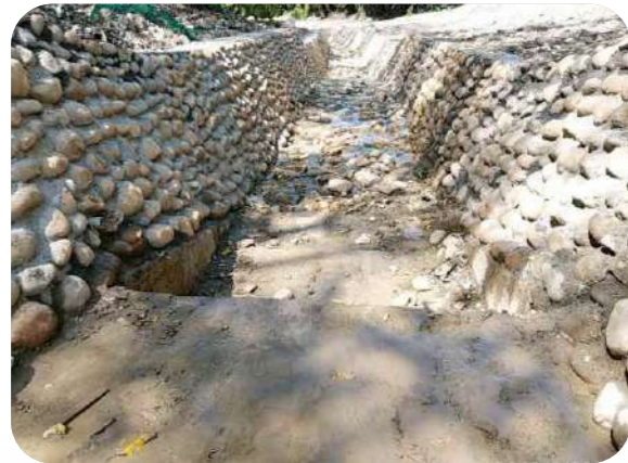
▲ 圖 4-3 機場捷運A7站地區區段徵收公共工程第六標-蝕溝編號1完工照片
