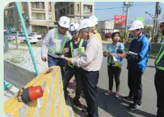
▲ 圖 4-40 臺中市捷運文心北屯線機廠及車站區段徵收工程-第五區」施工督導情形
