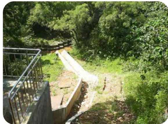
▲ 圖 4-4 機場捷運A7站地區區段徵收公共工程第六標-蝕溝編號4完工照片
