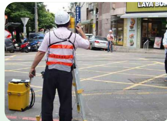
▲ 圖 4-30 現場樁位測定實況(一)
