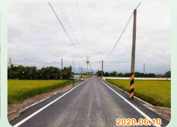
▲ 圖 4-22 臺南市白沙屯(十)早期農地重劃區農水路更新改善後情形
