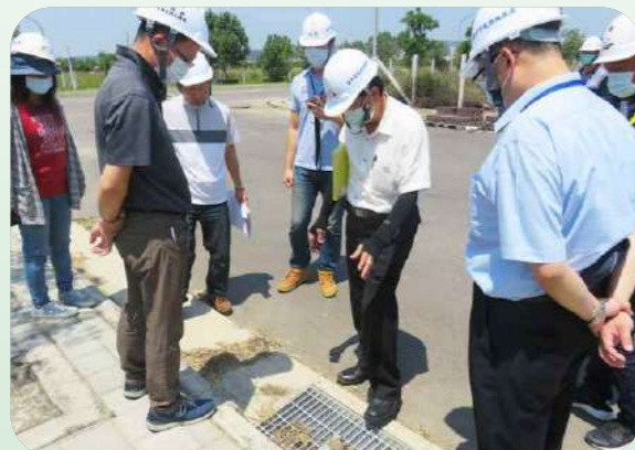
▲ 圖 4-47 「臺中市新八自辦市地重劃區重劃工程」施工督導情形
