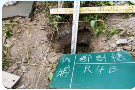
▲ 圖 4-33 都市計畫水泥樁埋設過程(b) 鐵蓋開挖深度及寬度確認
