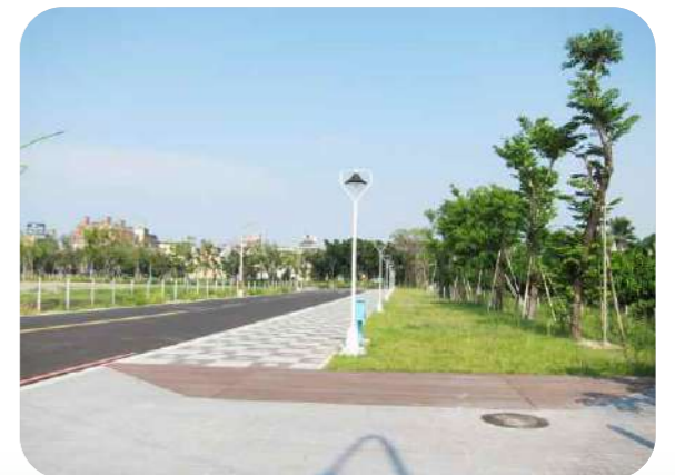
▲ 圖 4-10 臺中市豐富專案區段徵收工程- 綠地兼滯洪池用地完工照片
