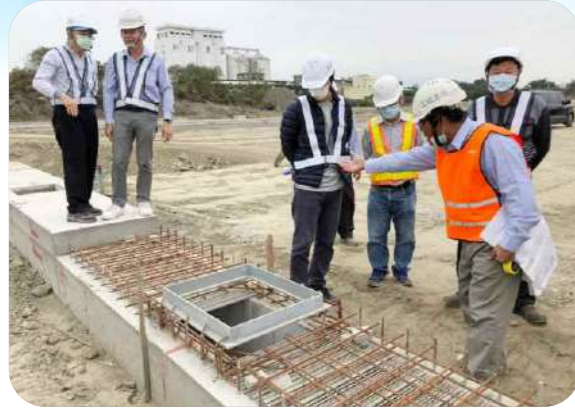
▲ 圖 4-42 「雲林縣斗南鎮小東市地重劃工程」施工督導情形
