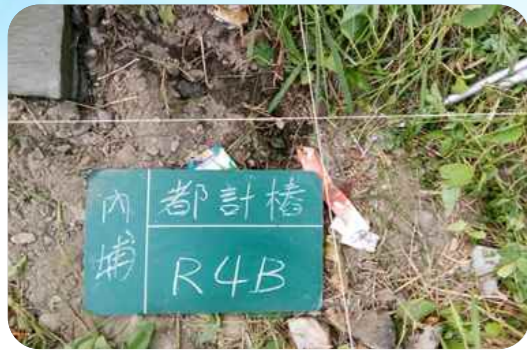
▲ 圖 4-32 都市計畫水泥樁埋設過程(a) 樁位施工前開挖
