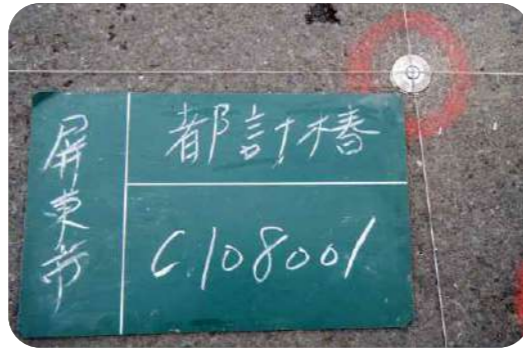
▲ 圖 4-35 都市計畫鋼標埋設
