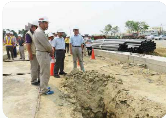
▲ 圖 4-44 「高雄市第92期市地重劃工程」施工督導情形
