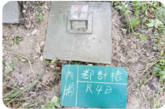
▲ 圖 4-34 都市計畫水泥樁埋設過程(c) 水泥樁施工完成
