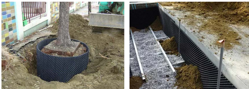
圖 21 行道樹樹穴導根版鋪設示意圖【20】
