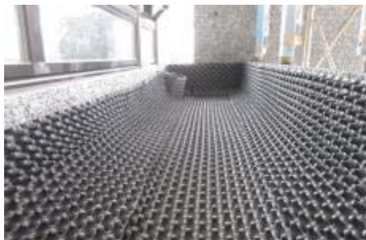
圖 20 花台植栽槽導根版鋪設情形 【C19】
