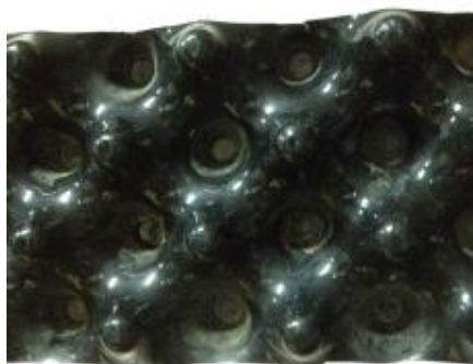
圖 20 花台植栽槽導根版鋪設情形 【C19】
