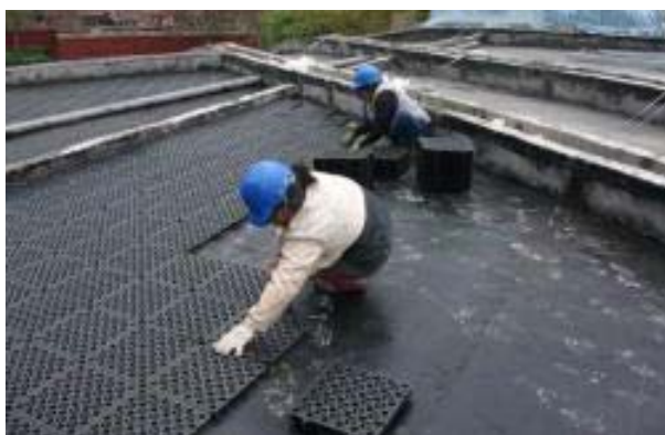
圖 19 屋頂綠化排水版之鋪設情形
