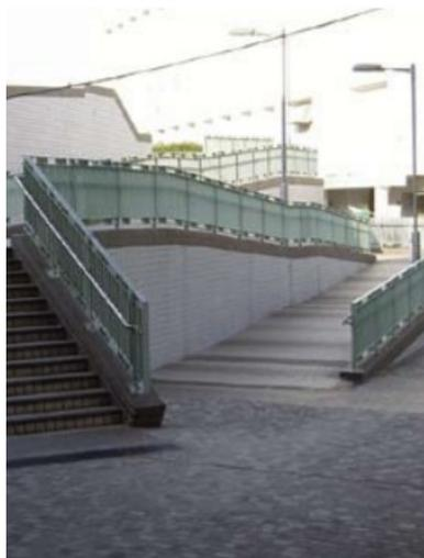
圖 2-14 平面高度有變的位置加設通達的斜道(左)
