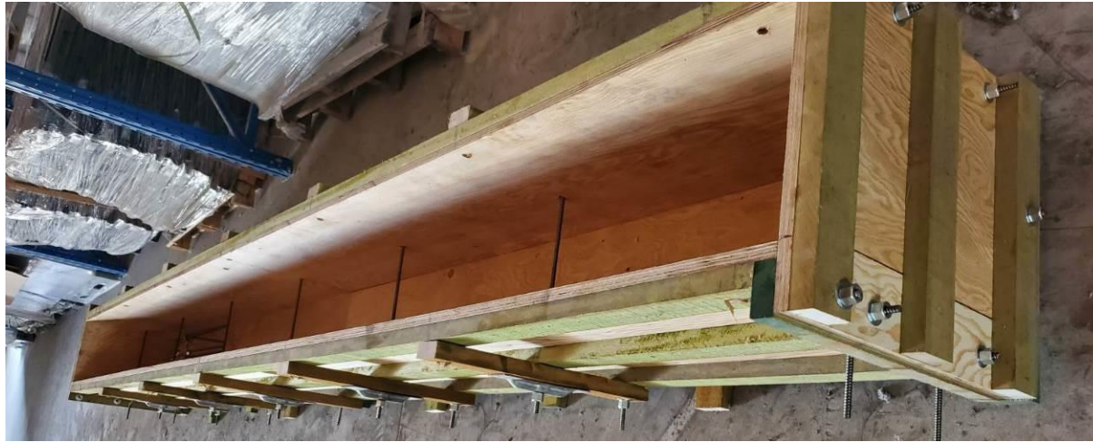
圖 3-5 製作完成的梁試體木模 (資料來源：本研究整理)
