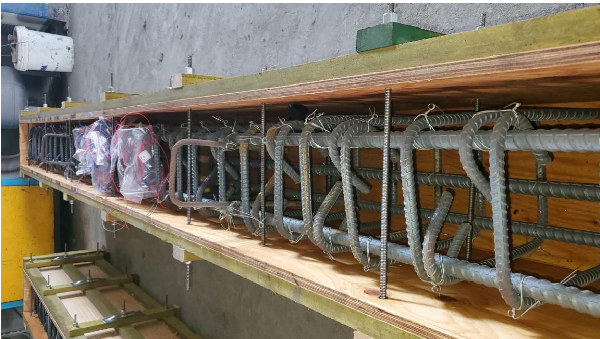
圖 3-16 組立好的梁試體模及鋼筋籠（資料來源：本研究整理）
