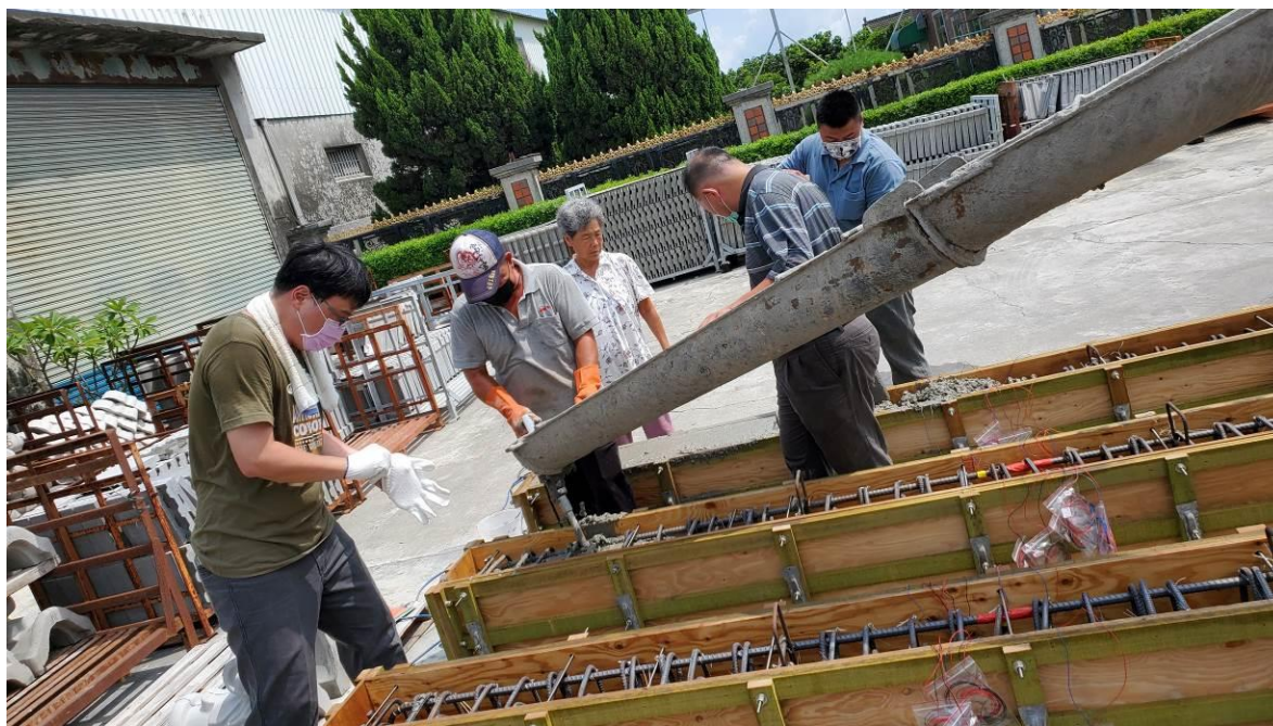
圖 3-9 梁試體澆置 (資料來源：本研究整理)
