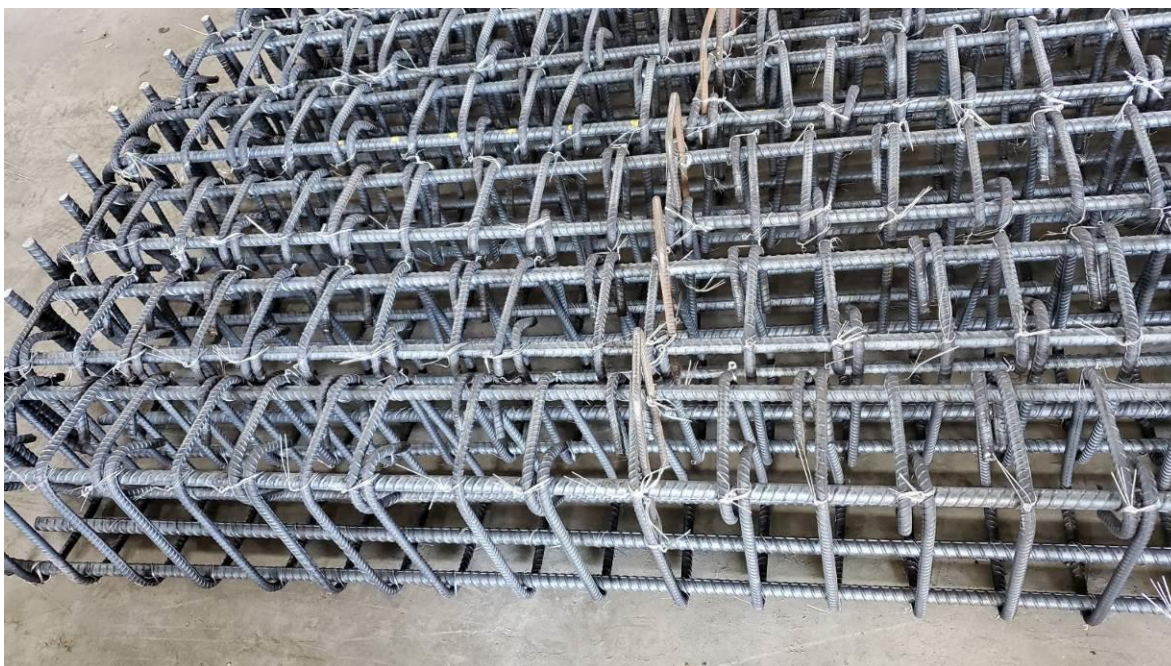
圖 3-17 製作完成的鋼筋籠（資料來源：本研究整理）
