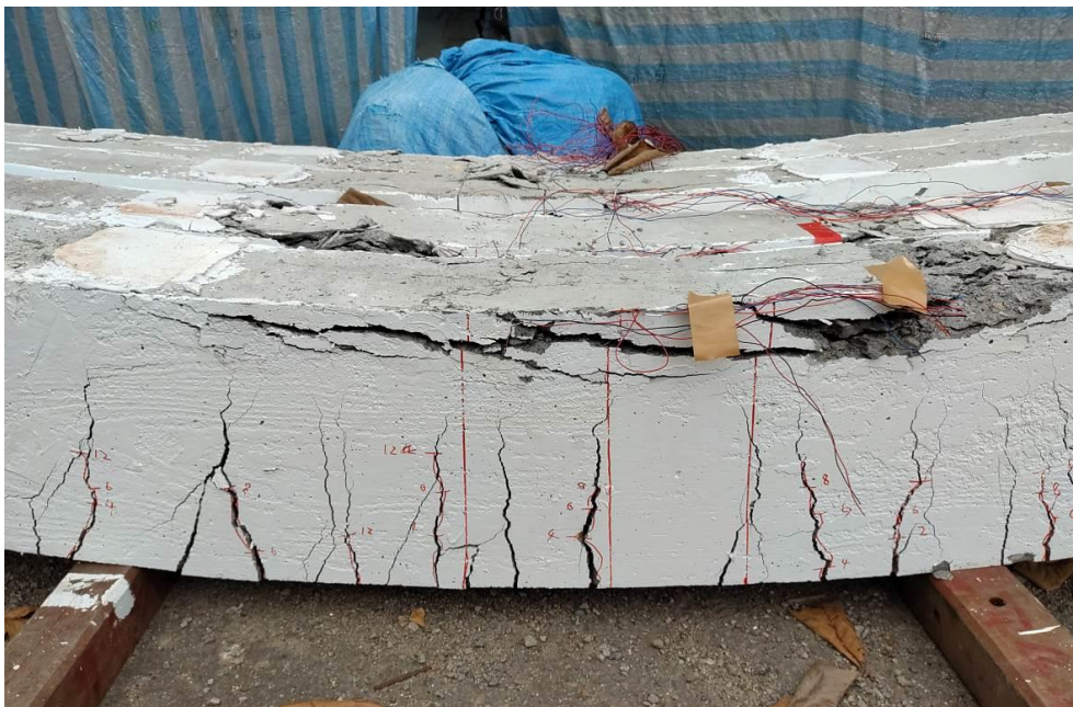
圖 4-19 蒸氣養護梁試體破壞情形(28 天) (資料來源：本研究整理)
