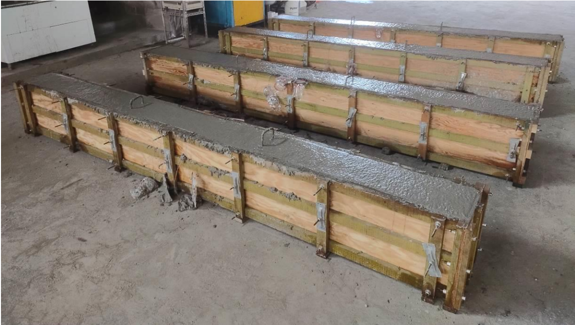
圖 3-11 製作完成之梁試體（資料來源：本研究整理）
