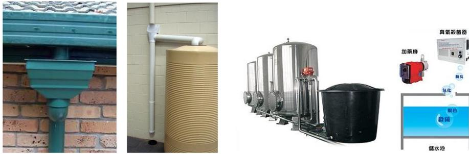
圖 2-5 初期雨水排除/分流設施及過濾設備
