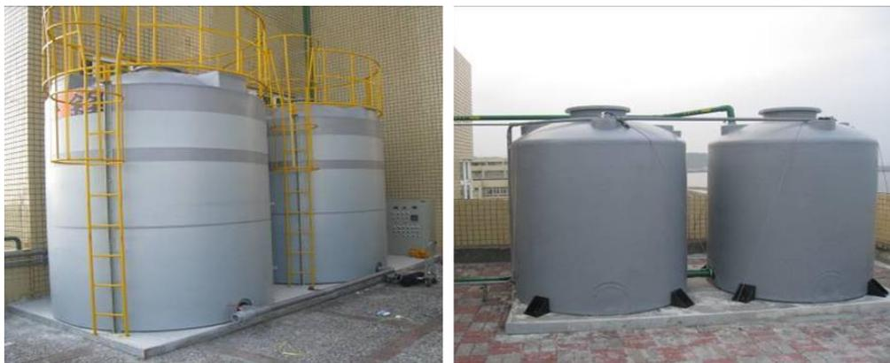
**圖 3-8 雨水貯留利用系統於沖廁用水設計貯水設施示意圖**
