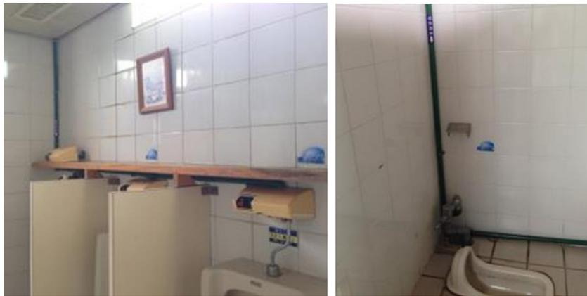
**圖 3-6 沖廁供水之管線示意圖**
