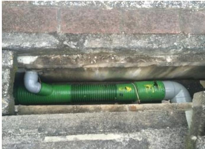
**圖 3-4 既有落水管線接管雨水收集示意圖**
