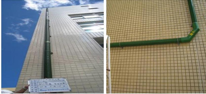
**圖 3-5 銑孔新設 HDPE 明管示意圖**
