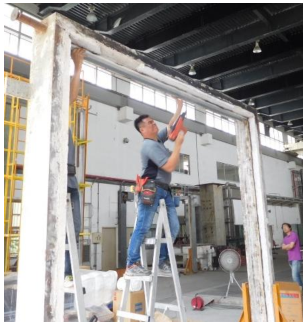
圖 5-4 固定上下槽鐵
