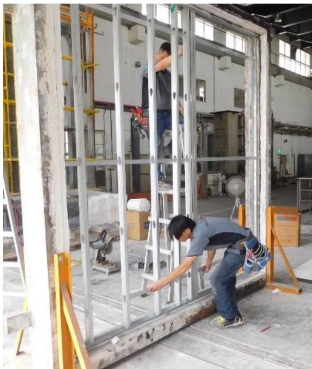
圖 5-7 安裝立柱與橫撐
