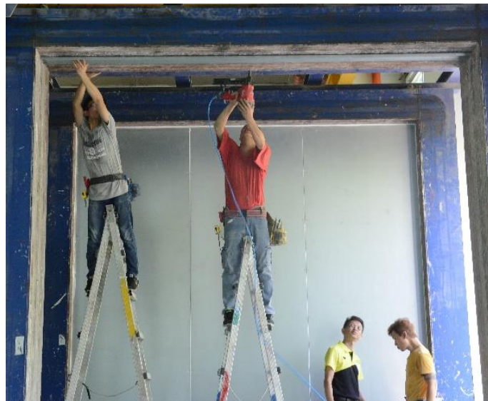
圖 5-28 安裝上下槽鐵
