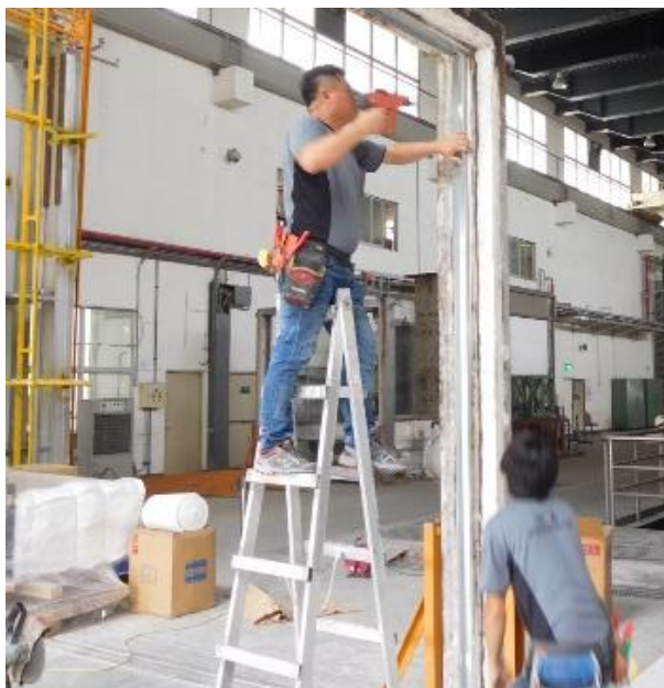
圖 5-5 固定一側邊框立柱
