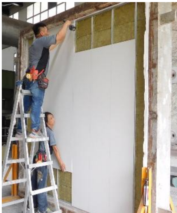
圖 5-11 非曝火面封板
