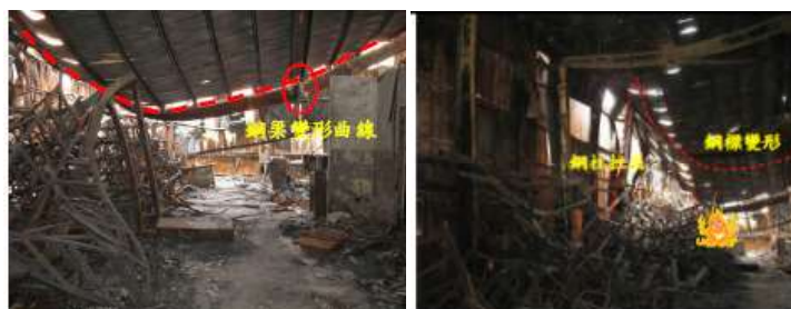
圖 3-15 鋼樑與鋼柱產生大量變形，造成屋頂塌陷
