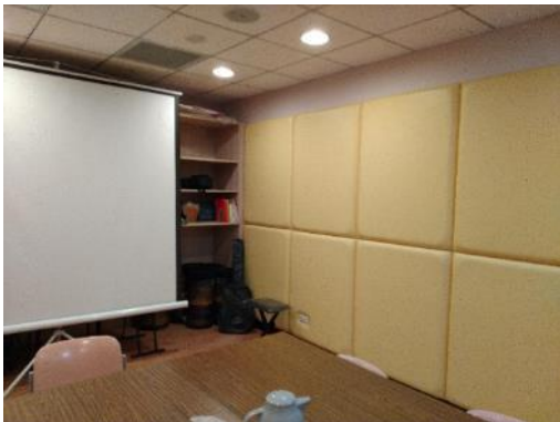
圖 5-74 活動室內鋪設吸音海綿
