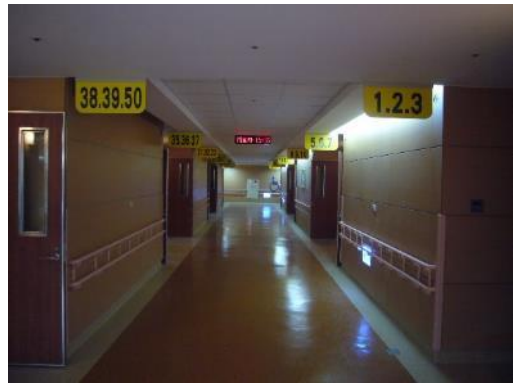
圖 5-130 設置扶手的走廊
