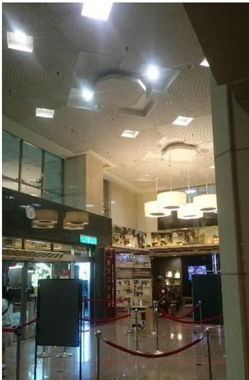
圖 5-153 大廳產生漫射光線的圓形燈罩
