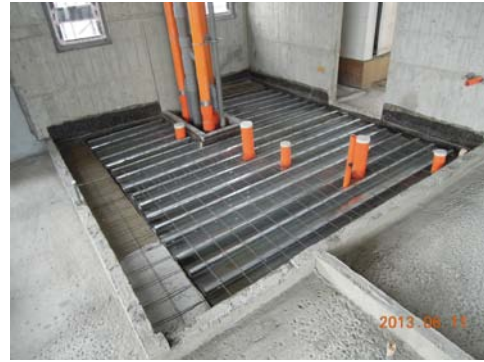
圖 4 複層版 DECK 板鋪設
