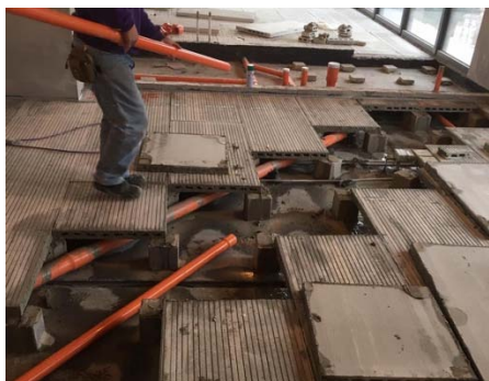
圖 7 無回填式架高配管施工過程記錄
