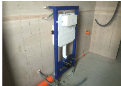
圖 9 當層配管-馬桶背牆水箱組件
