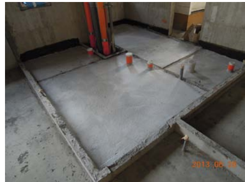
圖 4 複層版 DECK 板鋪設
