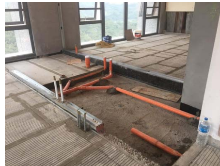
圖 7 無回填式架高配管施工過程記錄
