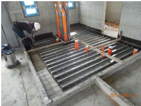
圖 3 降板區防水壓層、洩水坡度、管線配置作業
