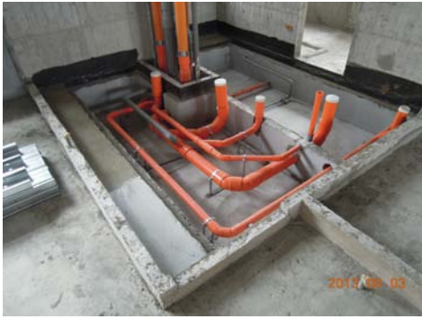
圖 3 降板區防水壓層、洩水坡度、管線配置作業
