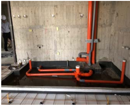
圖 8 當層配管現場施工照片
