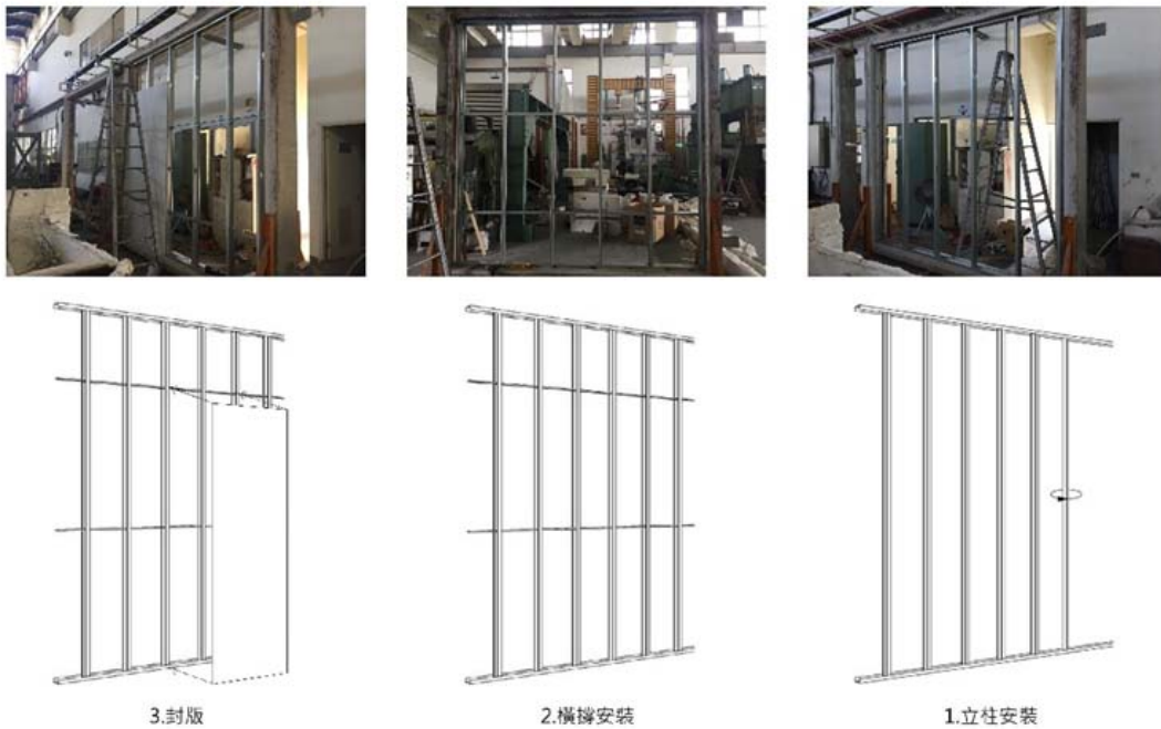
圖 1 簡易輕隔間牆工法試體組裝
