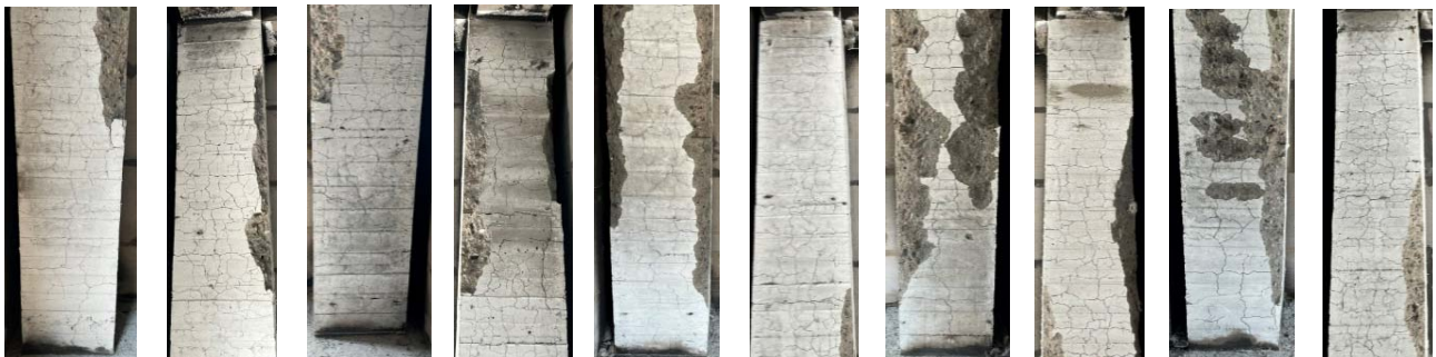
圖 23 F 試體火害後柱表面裂縫及混凝土剝落
