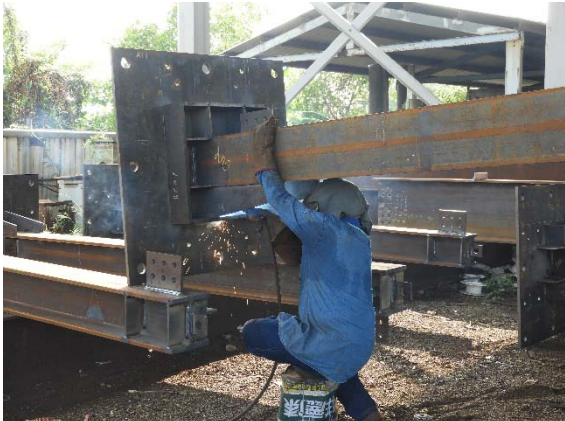
圖 43 實尺寸鋼構實驗屋之施作
