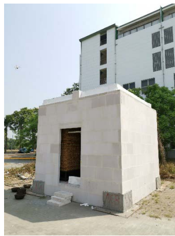
圖 3 隔熱白磚圍封與開口
