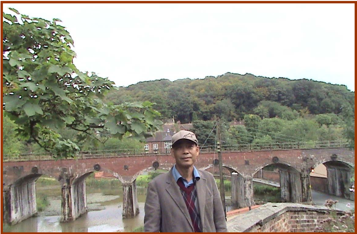
鐵橋谷博物館群中舊有鐵道之橋墩
