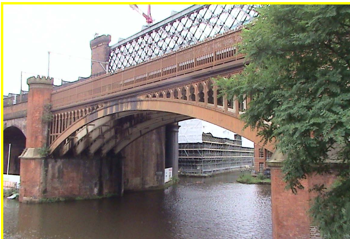
鐵道經過之橋梁，古色古香仍保留原有風貌。
