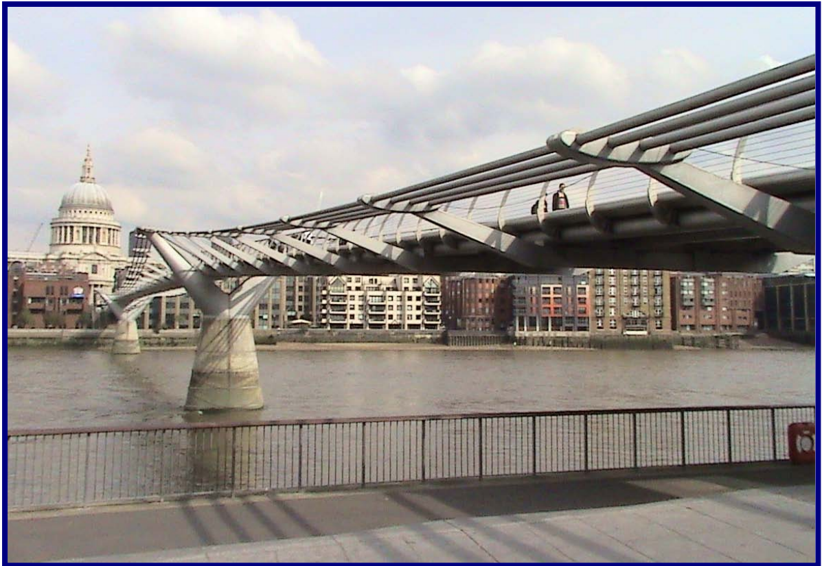
倫敦泰晤士河上 2000 年通車的千禧橋
