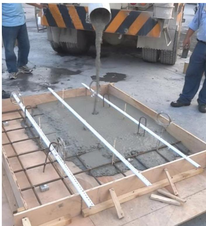
**圖 3-12 板試體澆灌情形**
