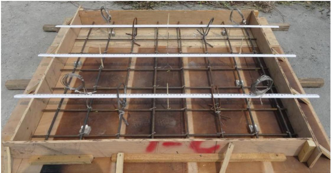
**圖 3-5 板試體模板製作**
