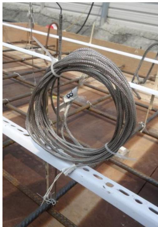
**圖 3-6 板試體量測元件佈設(熱電偶及壓力管)**
