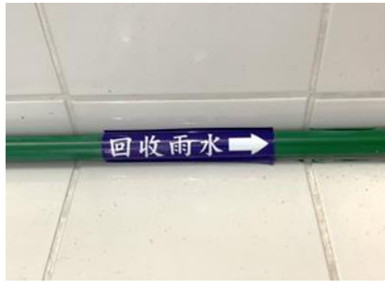
附圖 4-1 雨水輸送管道標誌示意圖
