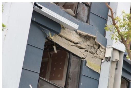
(d)梁保護層剝落鋼筋外露
