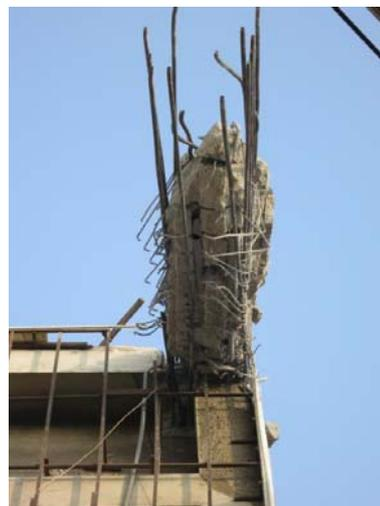
(d)柱箍筋 90°彎鉤
