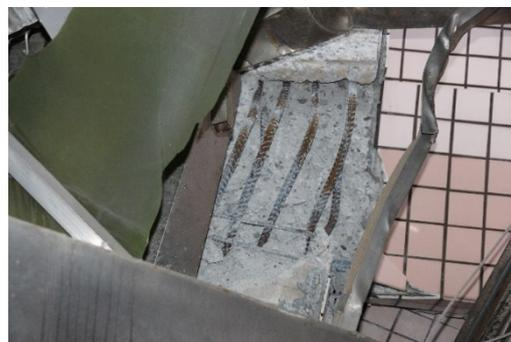
(d)柱主筋挫曲保護層混凝土剝落
