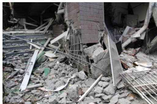
(d)一樓柱軸力破壞
