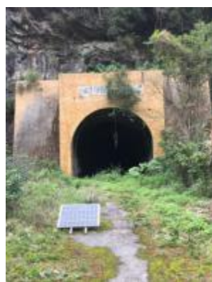
(2020.02.18) 溪畔過河隧道橋
