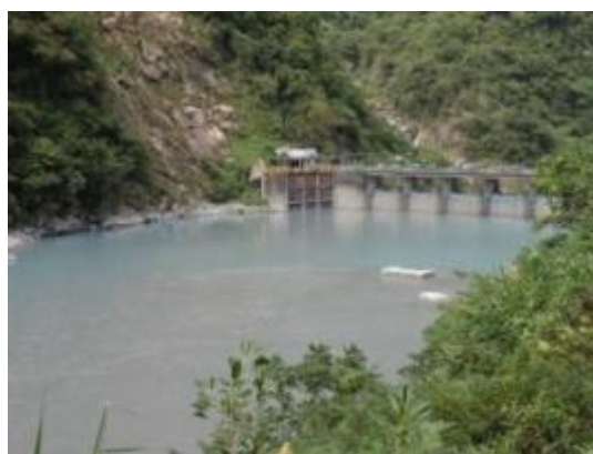
(2019.10.15) 溪畔壩上(高水位)
