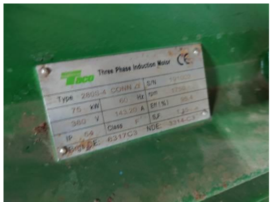
空調設備現況照片-10(CWP-1~3 75kW)
