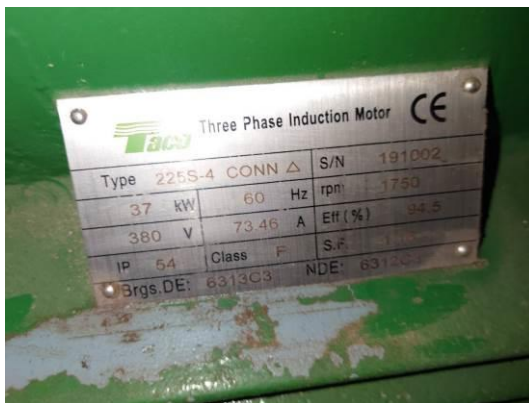
空調設備現況照片-9(ZP-1~6 37kW)
