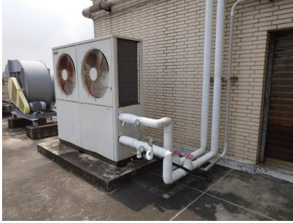
空調設備現況照片-5(10F 氣冷冰水機)
