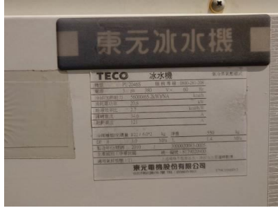
空調設備現況照片-6(氣冷冰水機耗電 20.8 kW)
