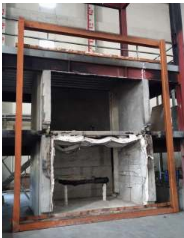
圖 4-30 未整修前試驗屋外觀
