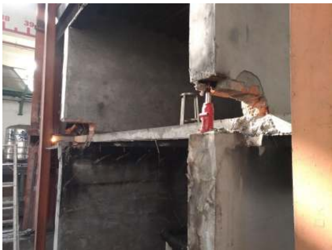
圖 4-32 樓板切除過程
