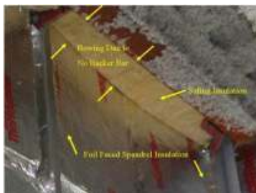
圖 3-10 未使用支撐柱而引起層間塞
