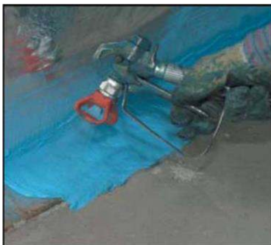
圖 3-13 層間塞表面隔煙系統
