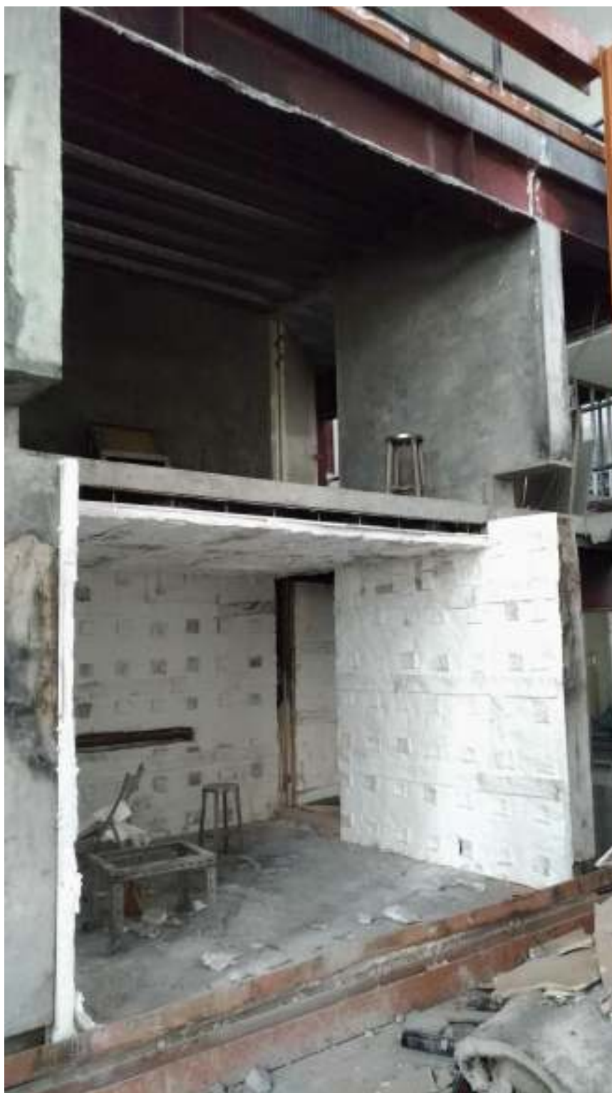
圖 4-34 測試室內部修護(二)
