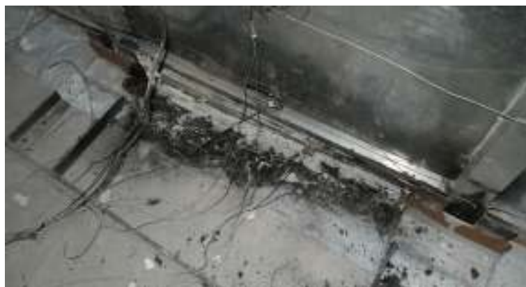
圖 3-54 層間塞非曝火面阻煙膠燒焦
