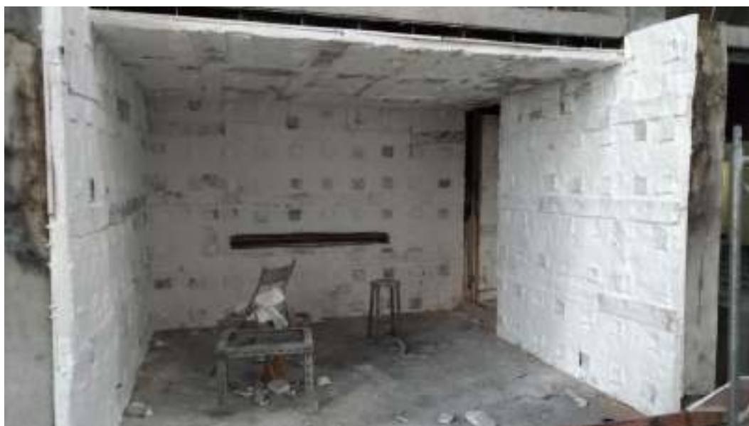
圖 4-35 測試室內部修護(三)
