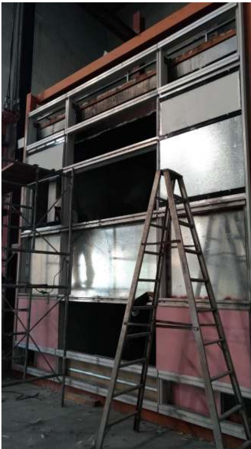
圖 4-7 鍍鋅鋼板安裝
