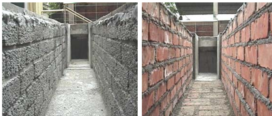
圖 2-8 滲透側溝實例
