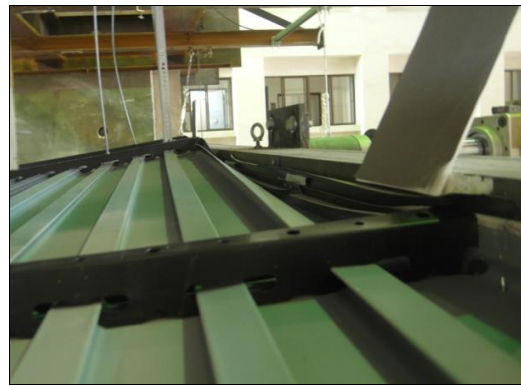
圖 84. T2 支撐架挫屈破壞
