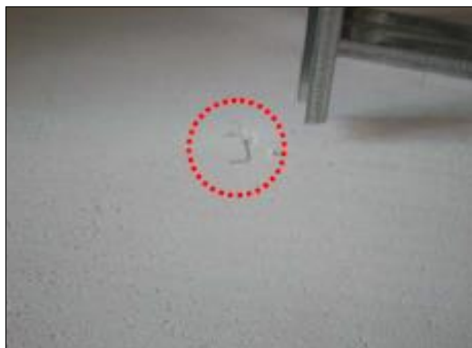
圖 34. 骨架撞擊結構體痕跡[11]
