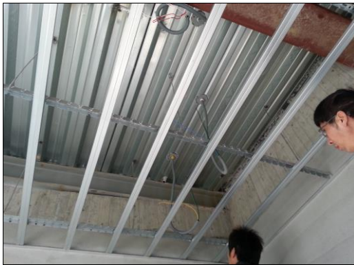
圖 8. 卡夾式暗架天花板系統
