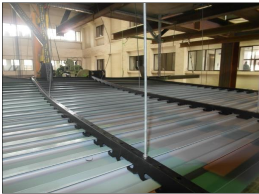
圖 83. T2 支撐架挫屈變形
