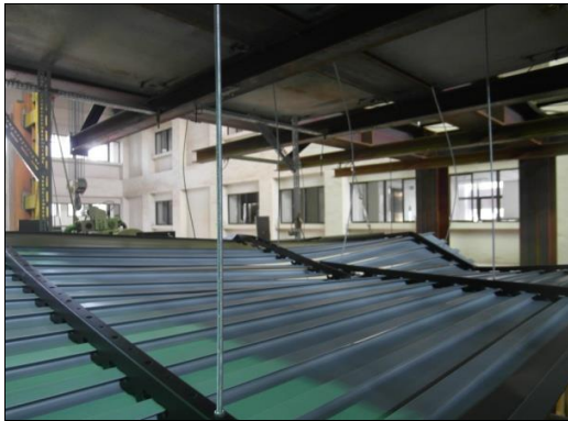
圖 109. T8 支撐架挫屈破壞
