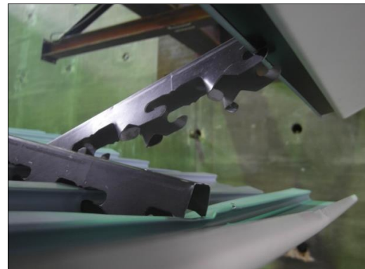
圖 97. T5 支撐架掛勾變形
