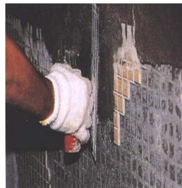
圖 21 素地整理作業-脆弱部之補修
