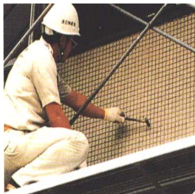
圖 20 素地整理作業-表面檢查
