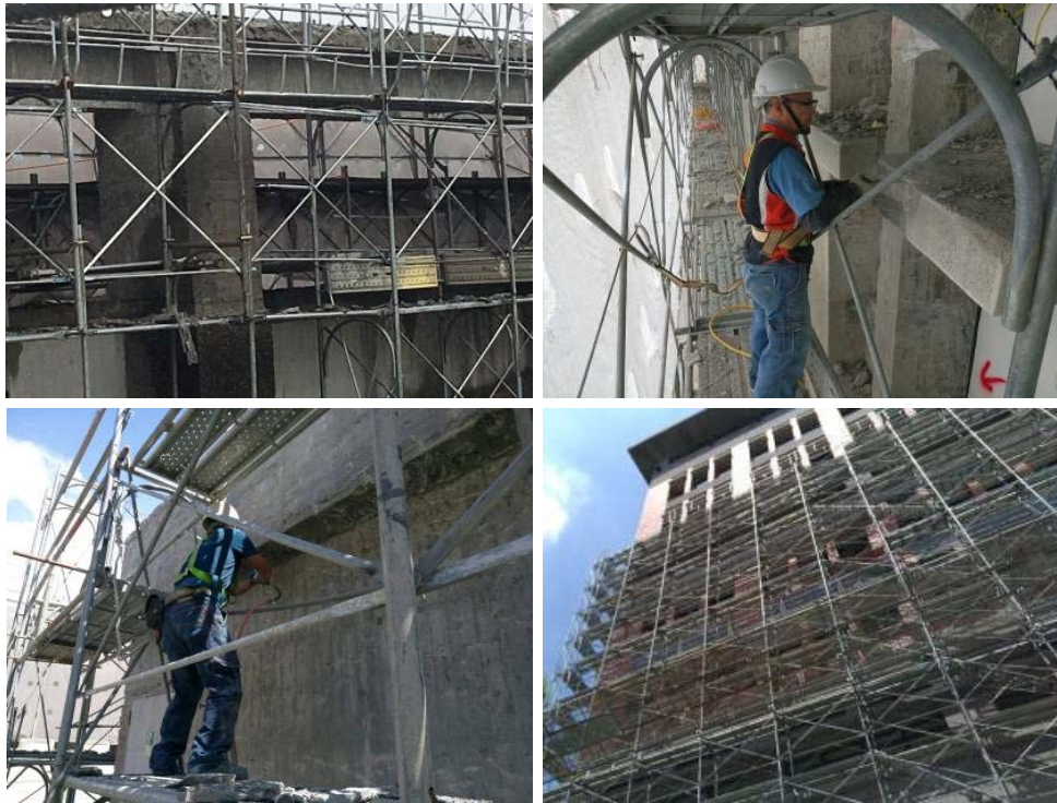
圖 16 瓷磚重貼改修法案例現況
