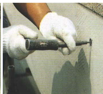
圖 31 穿孔固定-錨釘打入
