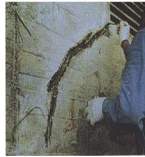
圖 25 素地整理 作業-龜裂之修補
