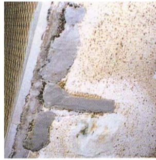
圖 23 素地整理 作業-缺損之修補
