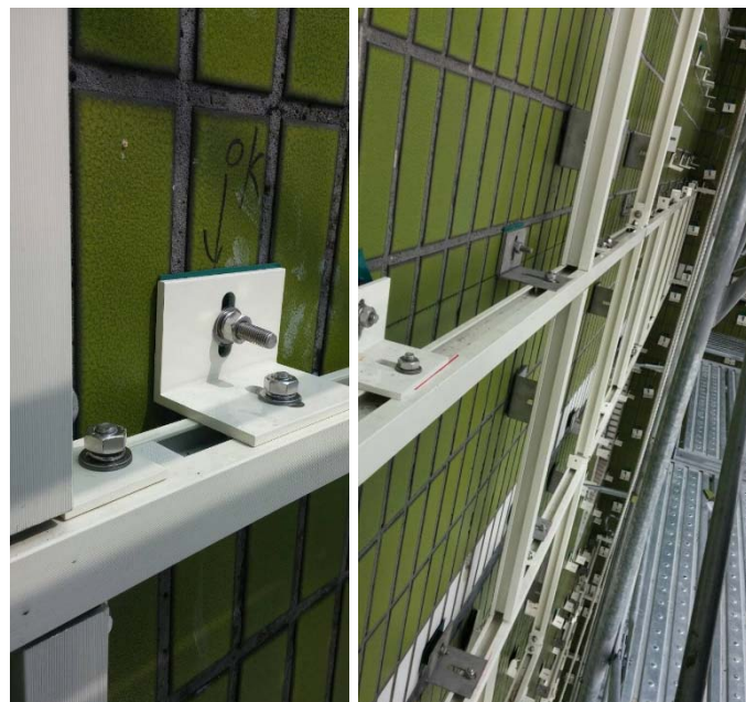
圖 38 乾式改修法案例現況-錨釘與骨架安裝
