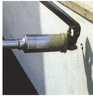
圖 24 素地整理 作業-浮起部之修 補
