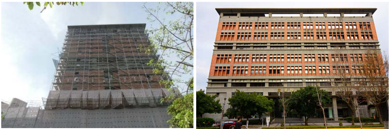
圖 15 瓷磚重貼改修法案例外觀
