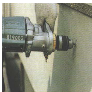
圖 30 穿孔固定-鑿孔
