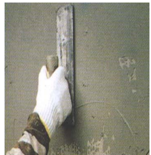
圖 29 纖維網固定-砂漿塗佈覆蓋
