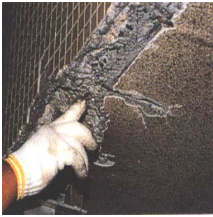
圖 22 素地整理 作業-鋼筋露出之 修補
