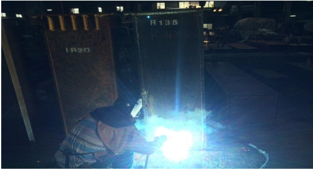
照片 2.3 箱型柱製作銲接 (資料來源：本研究製作)
