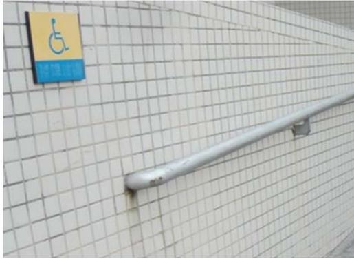
靠牆坡道可使用沒入牆面方式處理扶手端部。
