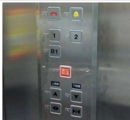
一般操作盤於按鈕左側需設置點字，數字與底板顏色明顯不同。
