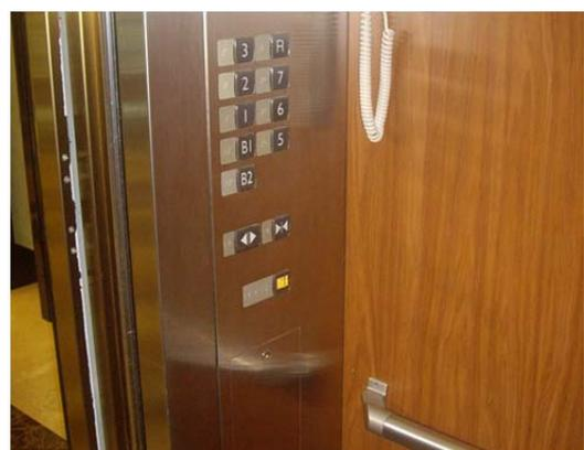
一般操作盤於按鈕左側需設置點字，數字與底板顏色明顯不同。
