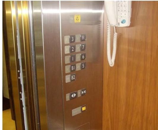
圖 4-6 一般高度操作盤
