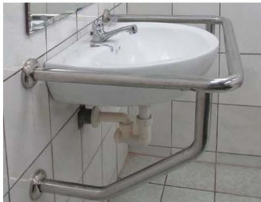
圖 5-34 不鏽鋼洗面盆扶手
