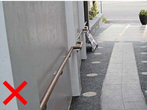
扶手不可依牆面凹凸而彎曲設置。
