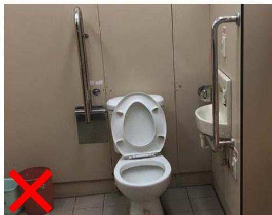
L 型扶手與掀起式扶手高度不相同，L 型扶手外緣與馬桶中心線之距離大於 35 公分，馬桶不可有蓋，小型洗手台會阻礙扶手使用。
