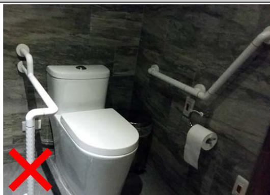
靠牆側 L 型扶手直桿應與橫桿垂直，另一側應設置掀起式可動扶手，馬桶不可有蓋，側牆面應設置手動沖水控制。
