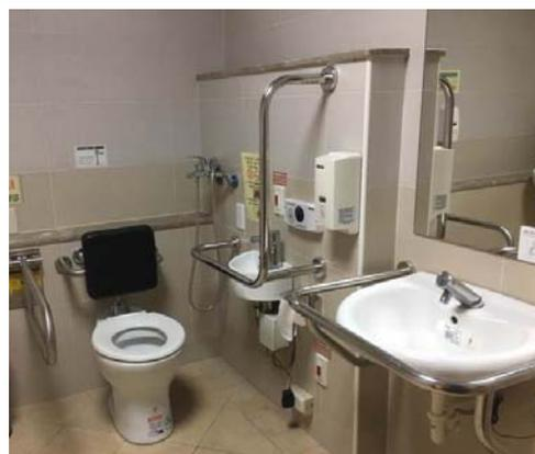
圖 4-18 L 型扶手內裝設洗手器實例
