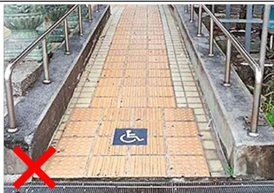
斜坡鋪面應保持平整、堅硬、防滑，不得設置導盲磚。
