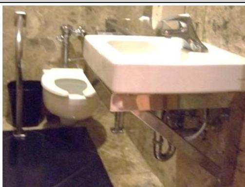
檯面式洗面盆裝設安全支架如圖所示，下方裝設支架應注意是否符合高度及膝蓋容納淨空間限制。
