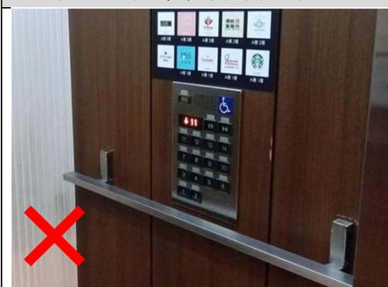
輪椅乘坐者操作盤不需設置點字，扶手不可使用方形扶手。
