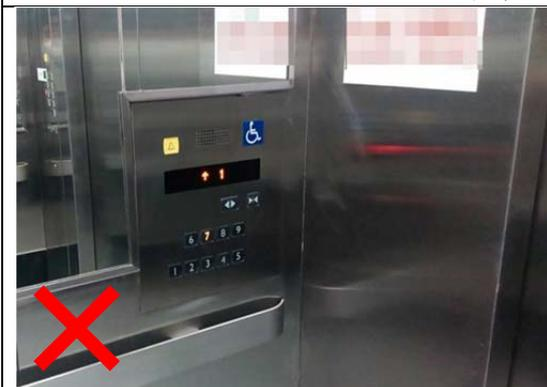
輪椅乘坐者操作盤裝設位置距離入口小於 30 公分，扶手設置樣式錯誤。
