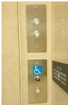
圖 4-7 一般高度呼叫鈕左側設置點字
