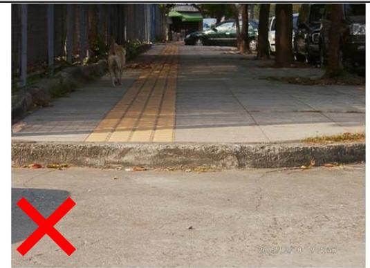
道路邊緣產生高低差，未依規定製作斜坡，使輪椅無法通行。
