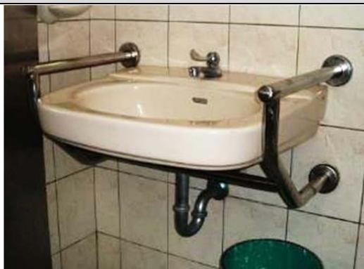
一般洗面盆裝設安全支架如圖所示，下方裝設支架應注意是否符合高度及膝蓋容納淨空間限制。
