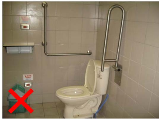
馬桶不可有蓋，上方求助鈴設置錯誤，L 型扶手中間固定點不得設於扶手垂直部分。
