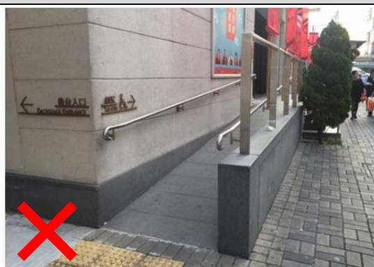
坡道前端不需設置導盲磚，扶手未設置防勾撞處理。
