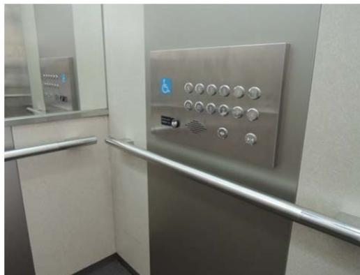
操作盤應符合與機廂入口壁面、入口對側壁面及機廂地板面距離。
