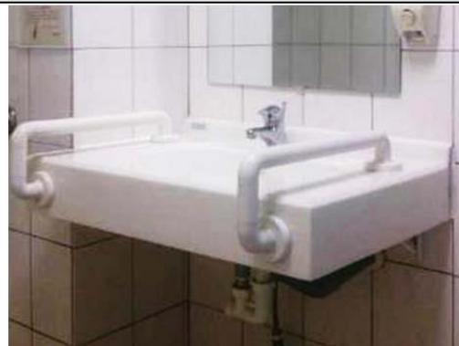
檯面式洗面盆之扶手設計方式可選擇裝設兩側，但扶手若僅固定於檯面無支撐作用，下方需裝設安全支撐。
