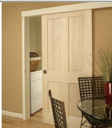
設置橫拉門可選用滑軌在上方的懸吊式拉門，使出入口無滑軌干擾。
