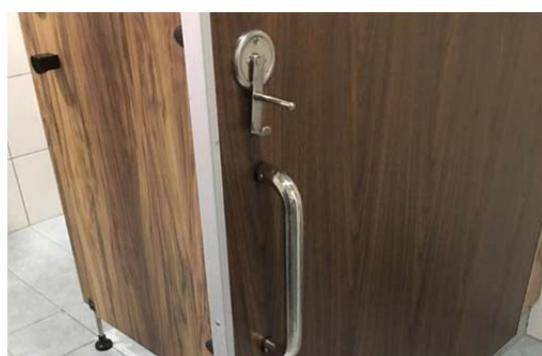
橫拉門如需要設置門鎖，有裝設長柄易於操作的扳手鎖較為合適。
