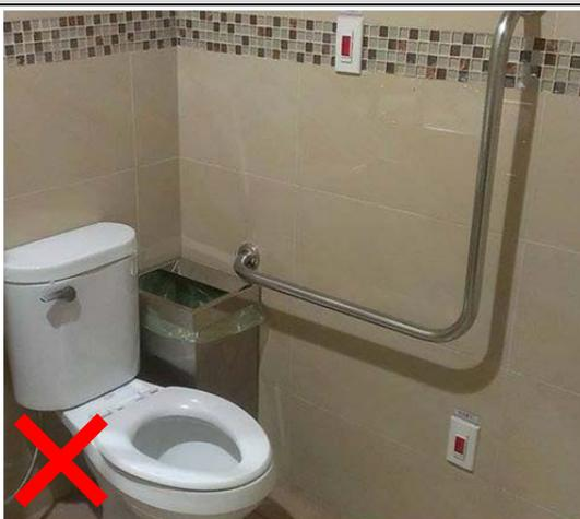
L 型扶手缺少中間固定點，側牆缺少手動沖水控制，上方求助鈴設置過高。
