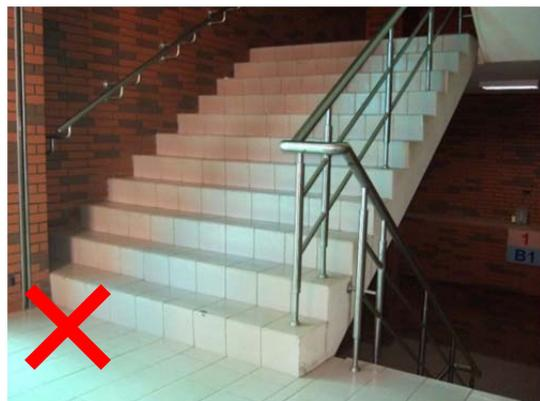
梯級終端未依規定設置警示設施，梯級邊緣未設止滑條，扶手未水平延伸 30 公分。
