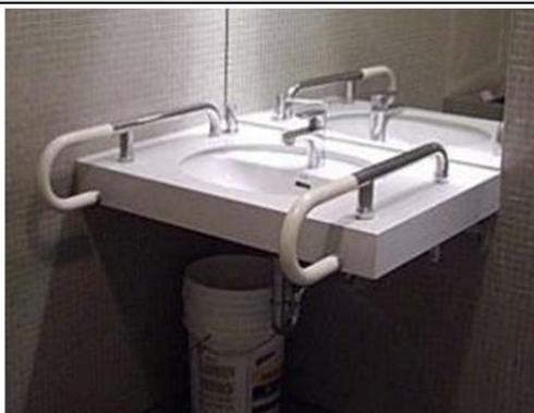
檯面式洗面盆之扶手設計方式可選擇裝設兩側，但扶手若僅固定於檯面無支撐作用，下方需裝設安全支撐。
