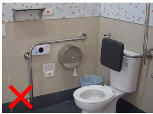
L 型扶手裝反，衛生紙供應器影響扶手使用，上方求助鈴設置過高。
