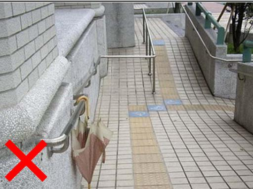
扶手不可依牆面凹凸而彎曲設置、坡度過陡、坡道材質不防滑、不可設置導盲磚。
