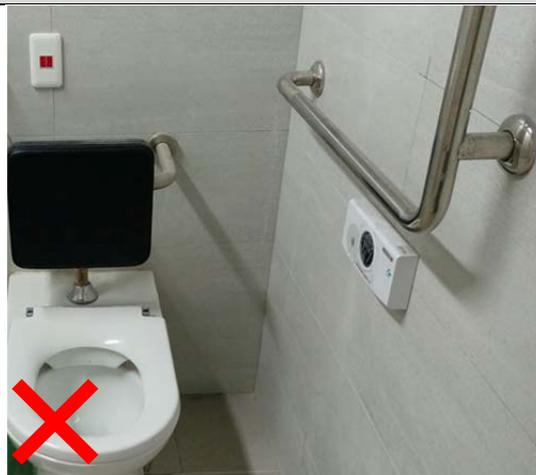
L 型扶手中央固定點不可設於垂直處，L 型扶手設置過高。
