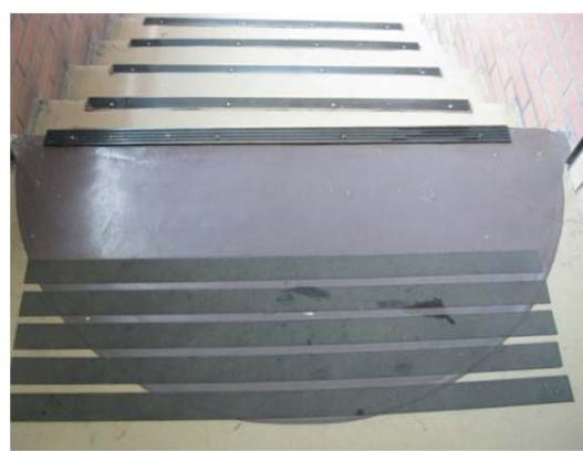
圖 3-25 金鋼砂終端警示
