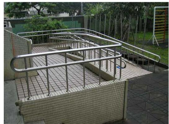
坡道起點設置端點平台，轉折處設置轉彎平台。
