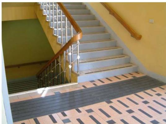
梯級終端設置金鋼砂警示設施，顏色與地坪材質顏色有明顯差異。
