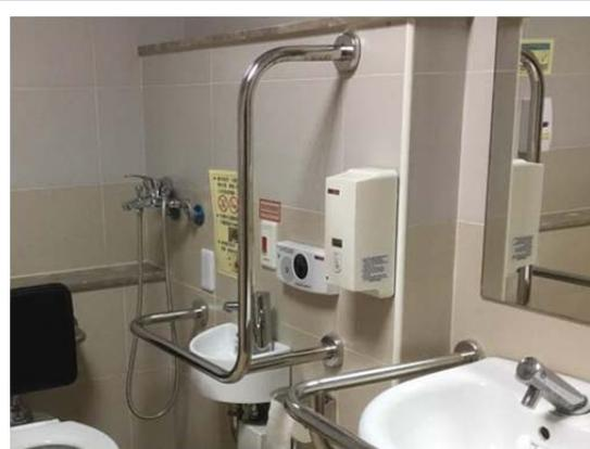
L 型扶手固定端可設置於直橫桿交界處，若扶手內側裝設洗手器或衛生紙架等附屬設備，需注意設備與扶手間距需大於 5 公分，且不得影響扶手使用。
