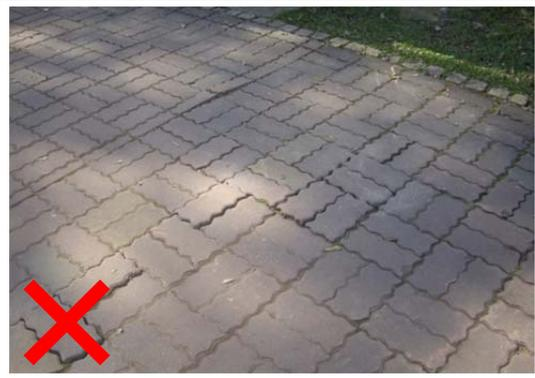
產生高低起伏的壓力磚不適合做為無障礙道路，可能出現不平整的路面突起，使視障者發生跌倒危險。
