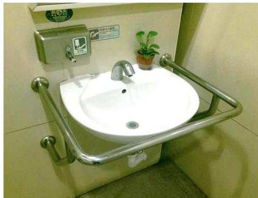
一般洗面盆裝設扶手如圖所示，需注意扶手邊緣至水龍頭操作桿距離、扶手高於洗面盆及距離及洗面盆邊緣與扶手之間距離限制。
