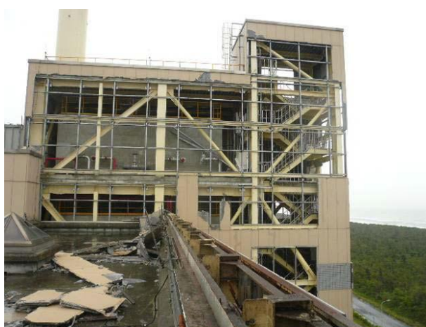
圖 2-2 利澤垃圾焚化廠萊特板破壞後場景 (資料來源：陳瑞鈴、張景鐘等，2012)
