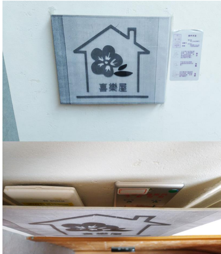
圖 三-36 以裝飾物件隱藏開關與插座，避免失智者使用 (資料來源：本研究團隊拍攝)
