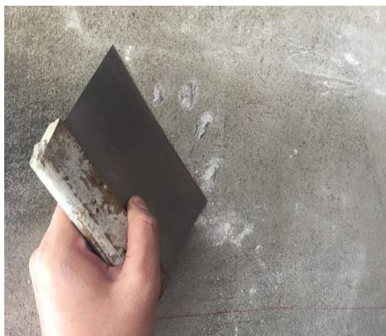
清理混凝土表面
