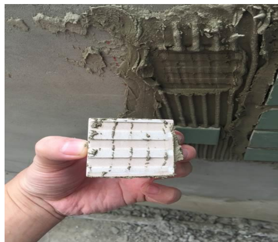
瓷磚鋪貼檢測
