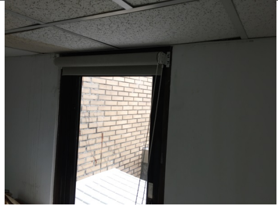
窗簾裝潢改裝成排煙風管路徑
