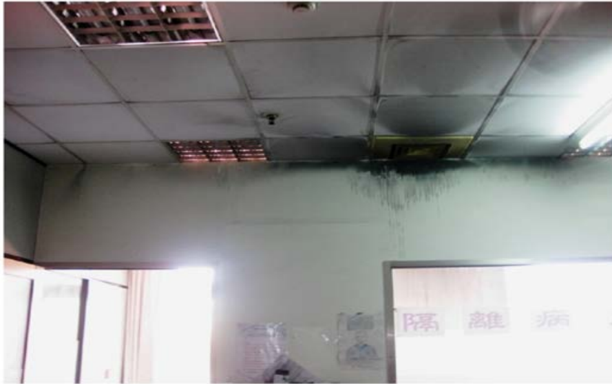
圖 1.7 護理之家病房區天花板送風口呈燻黑狀態，顯示濃煙已擴散至此。 (本圖取自參考文獻[6])
