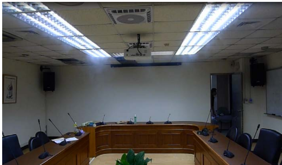
圖 5.31 煙塵經由空調風管輸送到各個送風口造成煙塵擴散
