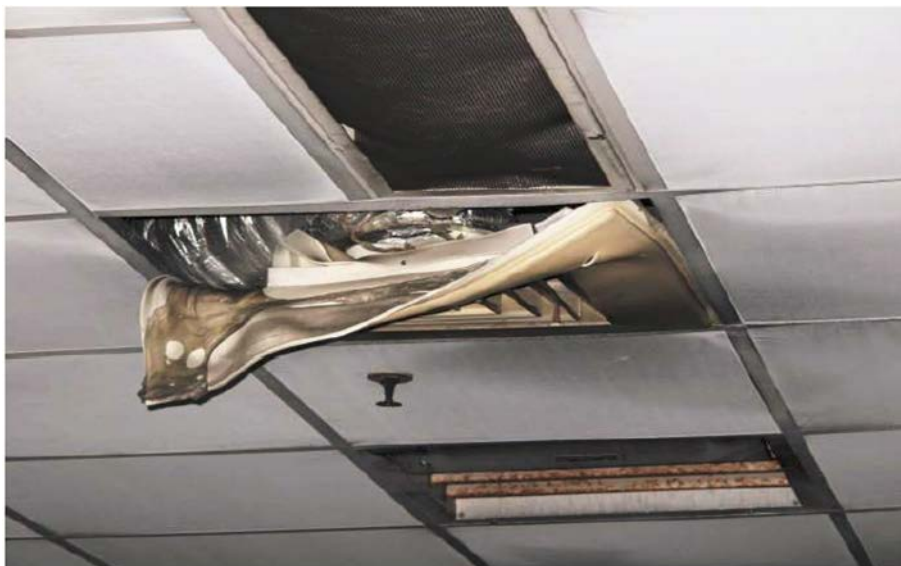
圖 1.8 走廊天花板空調送風口因熱煙溫度影響而變形 (本圖取自參考文獻[6])
