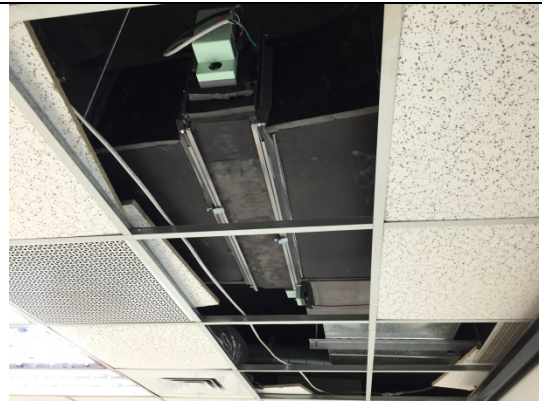
增設電動風門
