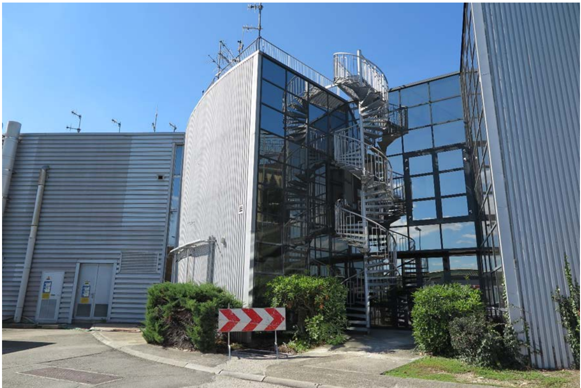
圖 6.2 室外安全梯設計案例(交通設施建築物) (本研究提供)
