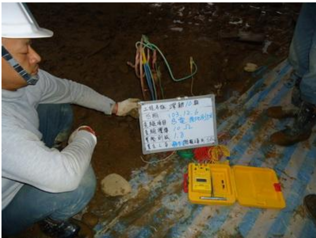
圖 2-2 正確的接地工程施工後需進行電阻量測，以確保功效
