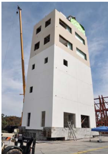
圖 2.12 美國加州大學聖地亞哥分校(UCSD) 鋼筋混凝土實驗屋(參考書目[59])
