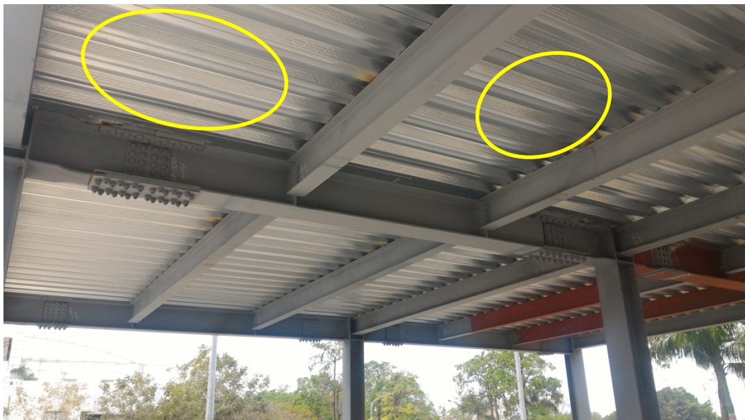
(b) 混凝土鋼承板
