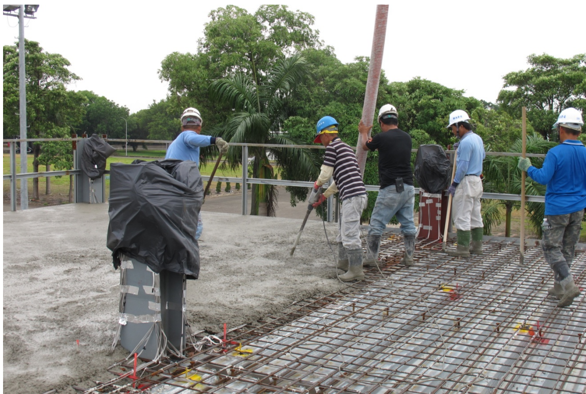
圖 3.12 樓板混凝土澆置中照片(本研究整理)
