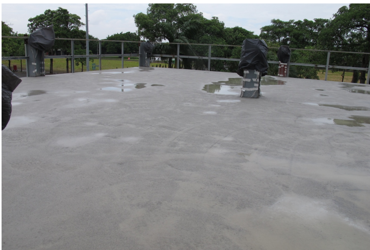
圖 3.13 樓板混凝土澆置完成照片(本研究整理)
