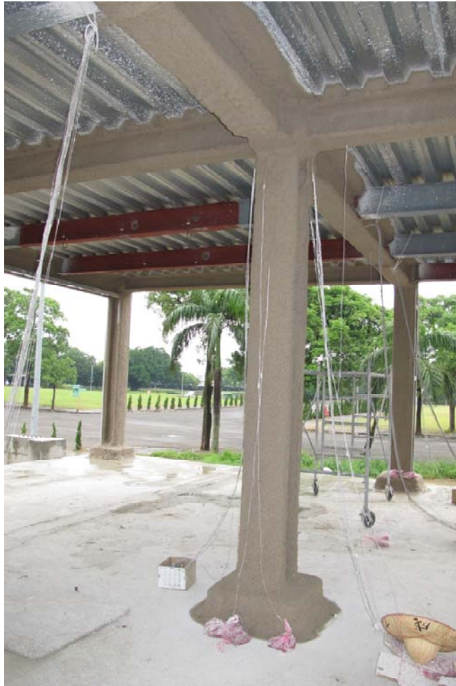
圖 3.18 火害實驗區內鋼柱與大梁施做防火被覆
