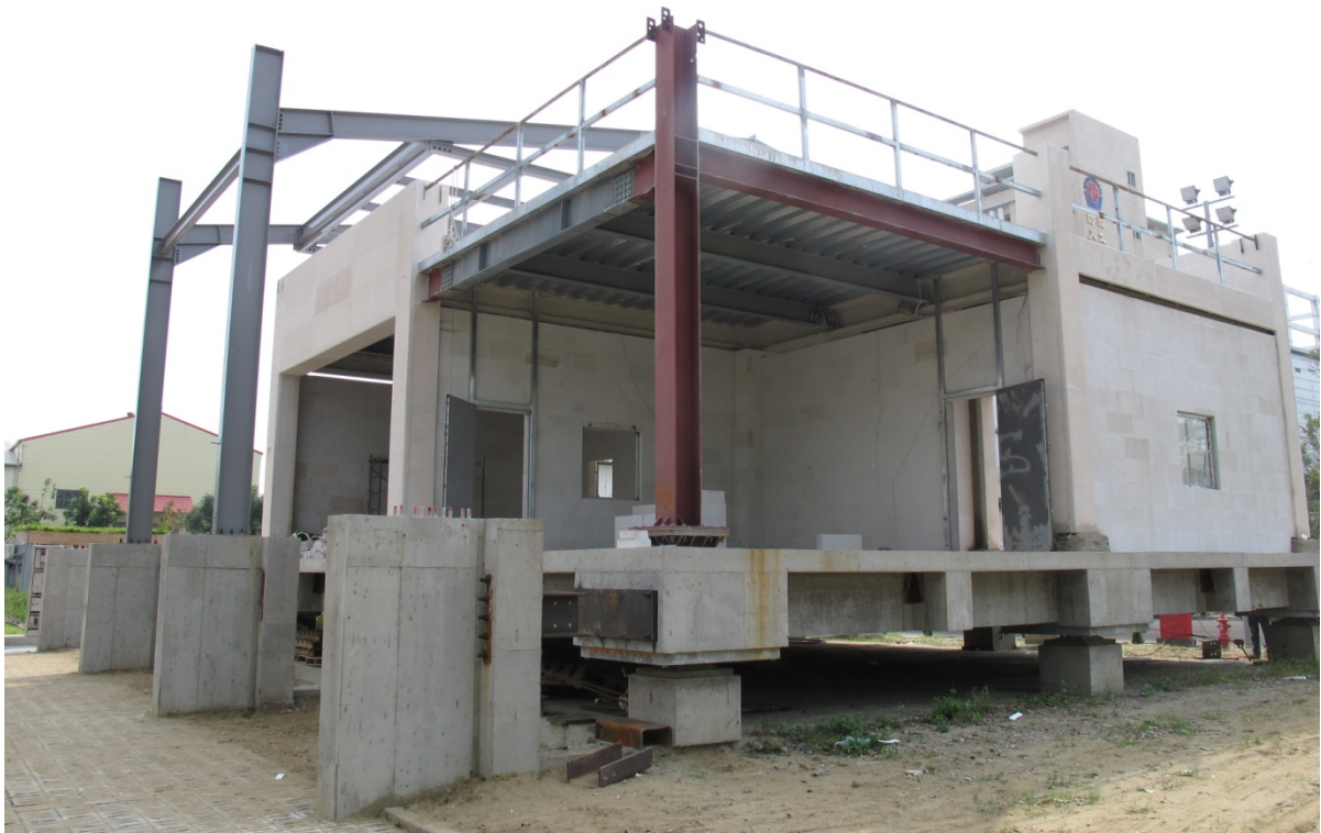
圖 3.23 火害實驗隔間完成照片
