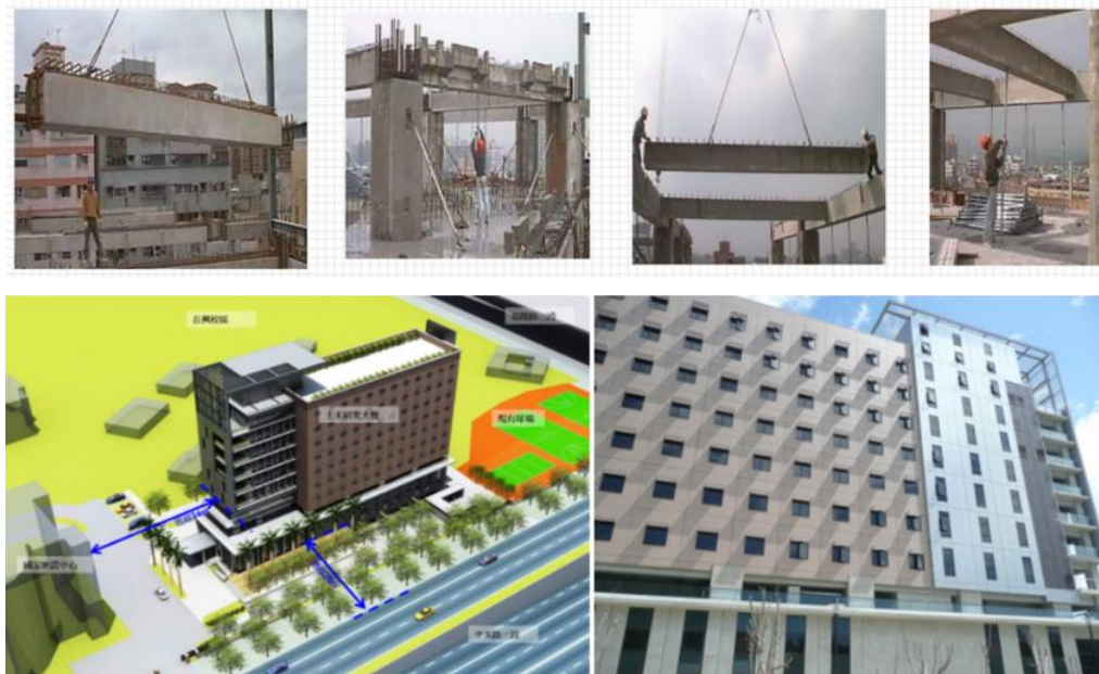
圖 3-4 台大土木大樓預鑄工程施工過程 (資料來源：[32])
