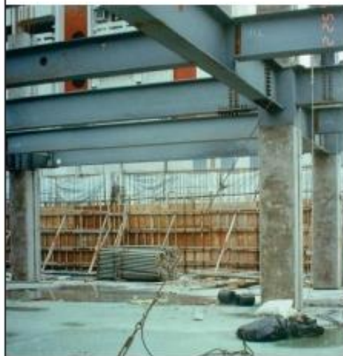
預鑄柱與鋼構主樑的節點照片
