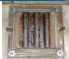
柱底滾動結構
