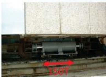
柱底滾動結構
