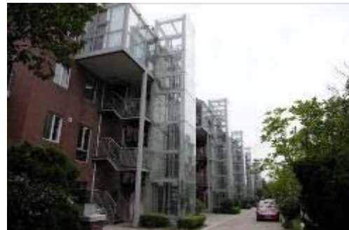
圖 4-15 中區低層住宅棟區
