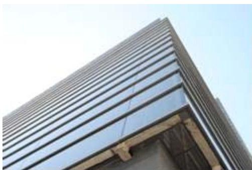
圖 4-77 世紀財富中心雙層外牆構造
