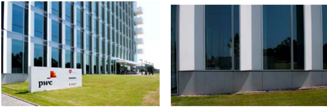
圖 4-114 西向立面垂直遮陽設計 (圖 4-101 至 114 本研究拍攝)
