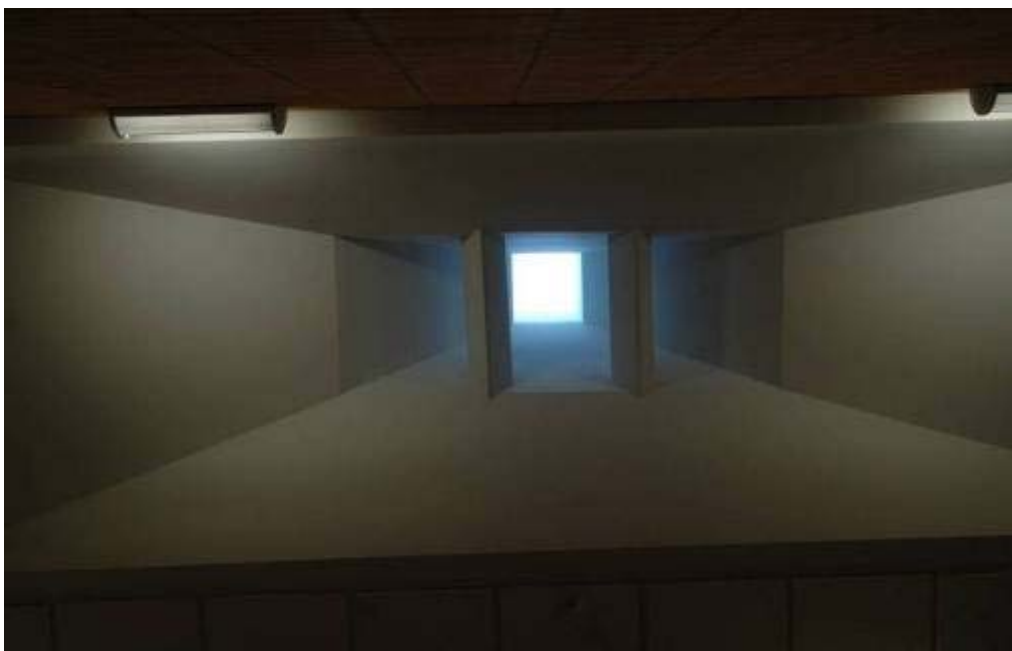
圖 4-119 芝加哥綠色科技中心採光天井與浮力通風口
