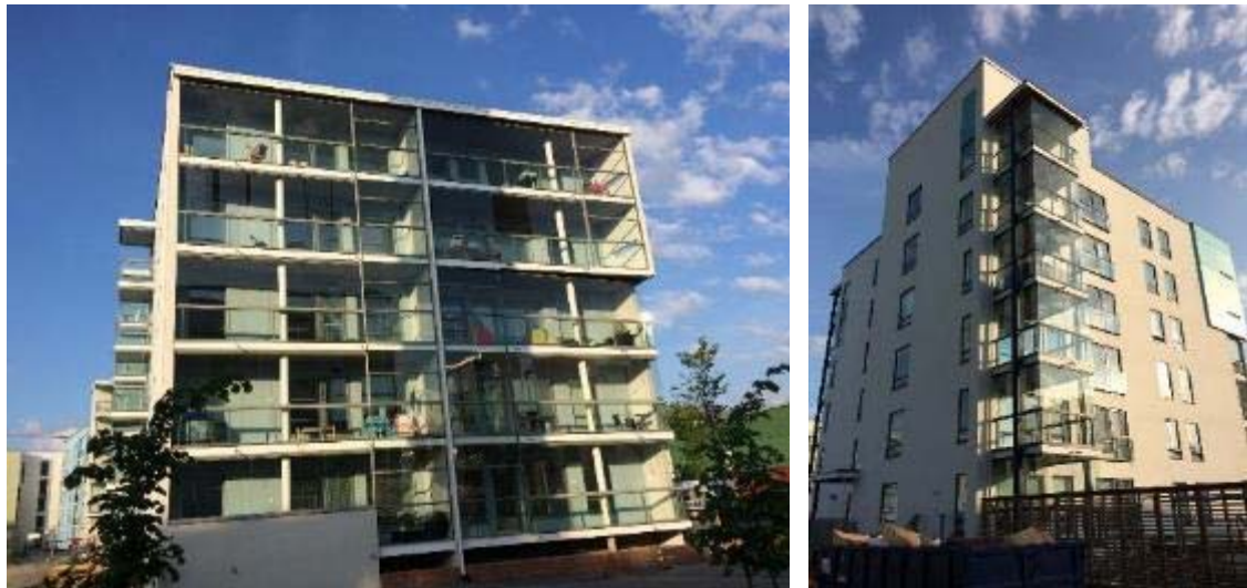
圖 4-92 Härmälänranta 永續住宅個案高反射外牆及導入南向日照
