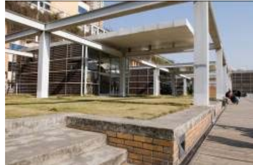
圖 4-49 建築物屋頂綠化現況
