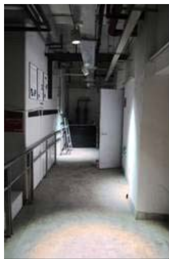
圖 4-57 地下室晝光導光光束照明裝置
