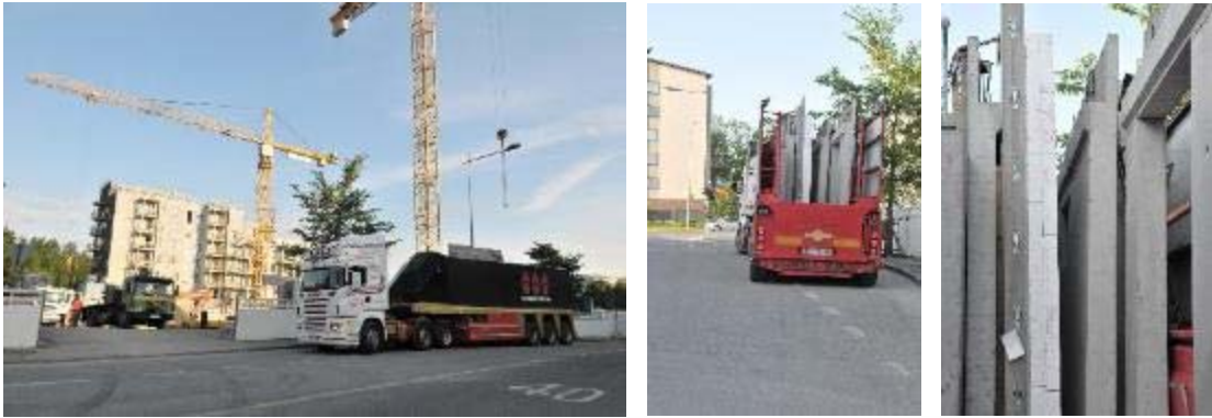
圖 4-97 Härmälänranta 永續住宅採預鑄式開放建築工法施作
