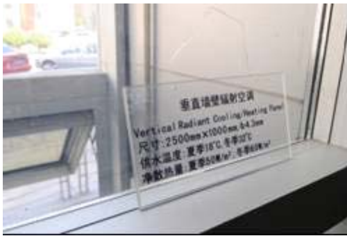
圖 4-58 節能研究中心垂直壁面輻射空調
