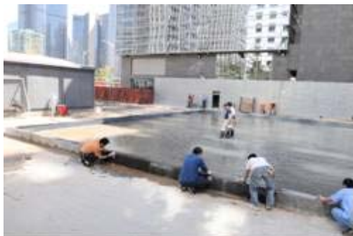
圖 4-83 戶外水景設施（施工中）
