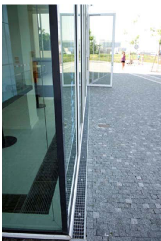
圖 4-113 西向立面遮陽板與敷地透水設計及雨水截水溝
