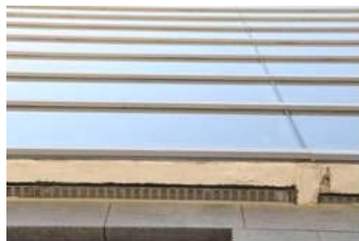
圖 4-78 雙層外牆空氣層進氣口
