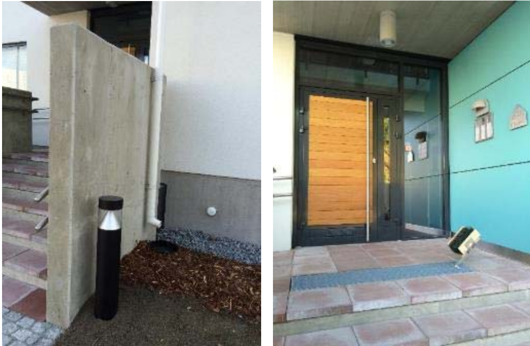
圖 4-93 Härmälänranta 住宅雨水排水管及玄關過篩導水格柵
