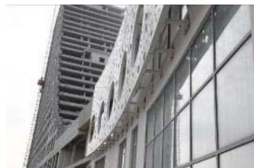
圖 4-32 青島藍色中心外牆 現況
