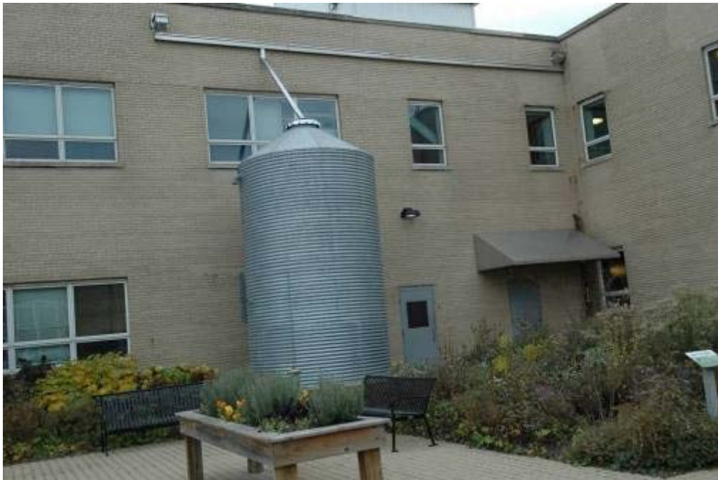
圖 4-121 芝加哥綠色科技中心雨水收集貯留槽
