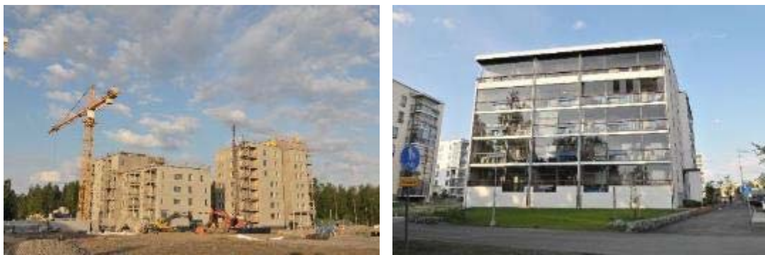
圖 4-98 Härmälänranta 永續住宅施工完成現況
