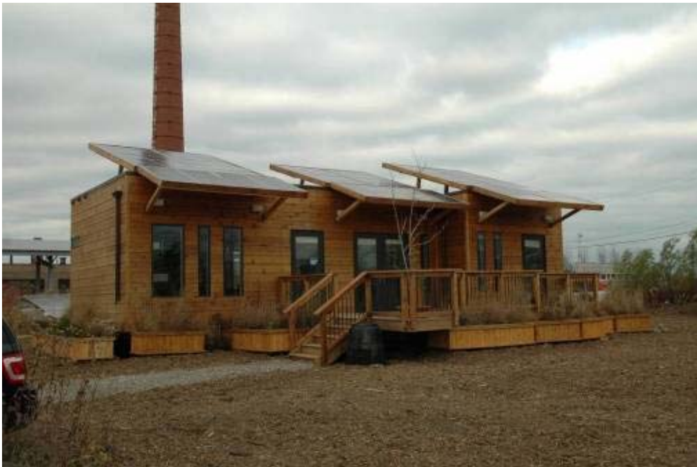
圖 4-124 與伊利諾大學共同建立的太陽光電發電與木構造實驗屋
