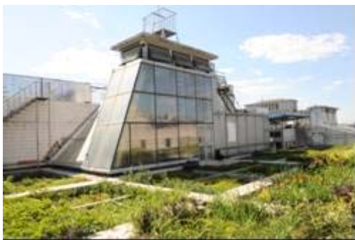
圖 4-64 節能研究中心浮力通風換氣井頂部
