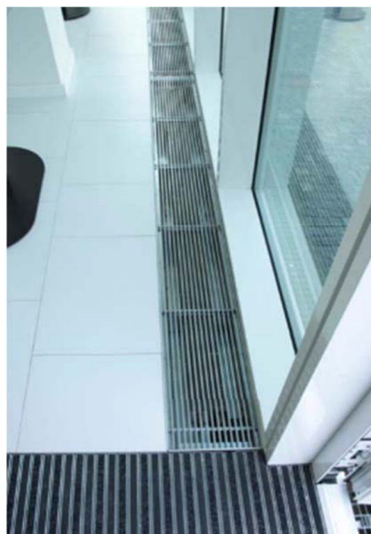
圖 4-112 地板出風式空調送風設計
