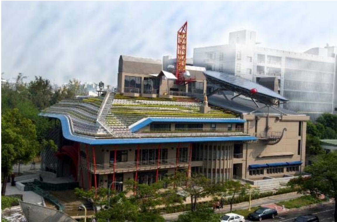
圖 2-15 成功大學孫運璿綠建築科技大樓 （本研究拍攝）
