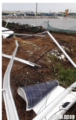
現場慘況猶如電影「明天過後」場景。
