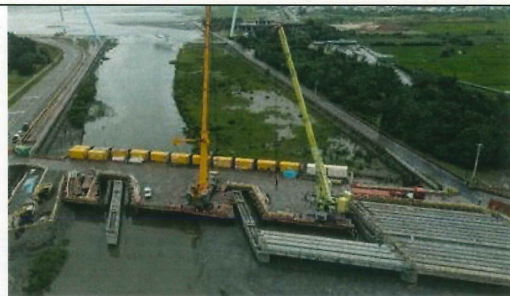
圖2 預鑄梁吊裝施工
