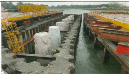
圖1 橋墩施工圍堰情形
