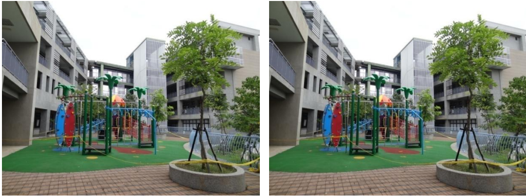
圖 3-15 國立科學工業園區實驗高級中學教室及運動場擴建工程現勘照片
