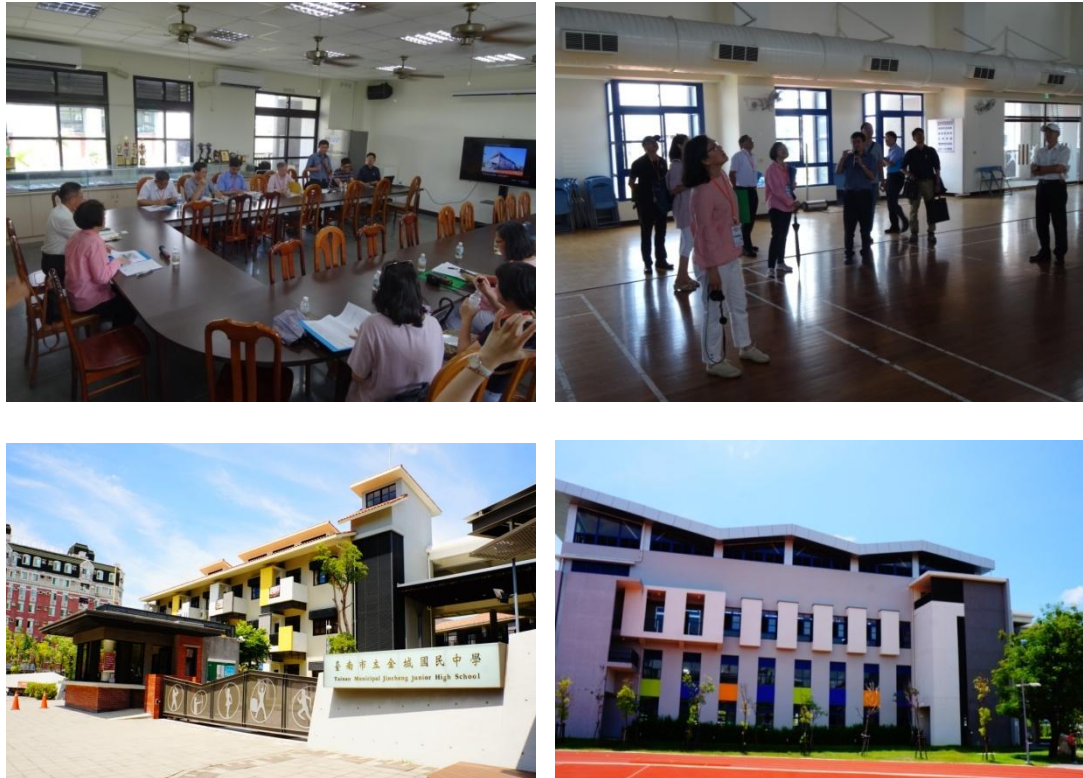
圖 3-21 臺南市金城國中遷校校園新建工程現勘照片
