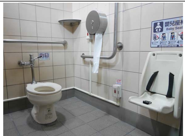
圖3-86 平板式嬰兒座椅不安全且馬桶座椅未設置靠背
