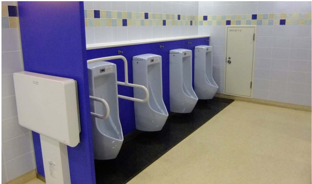
圖4-24男廁小便斗應留設置物空間、使用者特性及設置嬰兒尿布台
