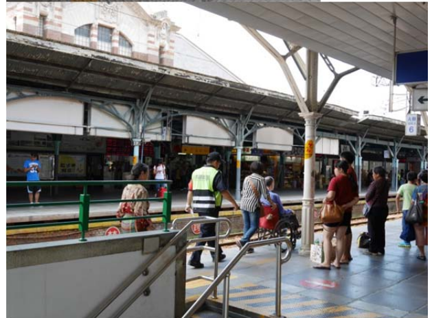
圖3-47月台警示磚已全面移除，用不同材質鋪面做為區隔
