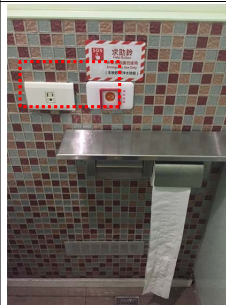
圖3-21廁所緊急鈴設置過高，又有置物架擋住
