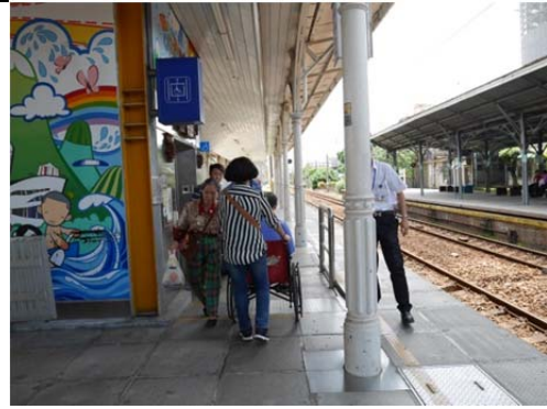
圖3-49月台上增設之電梯
