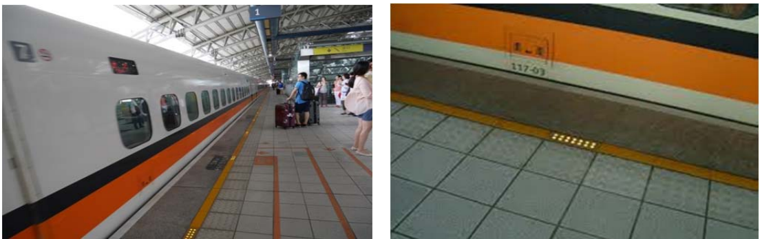
圖4-6 高鐵列車進站警示燈及警示磚系統
