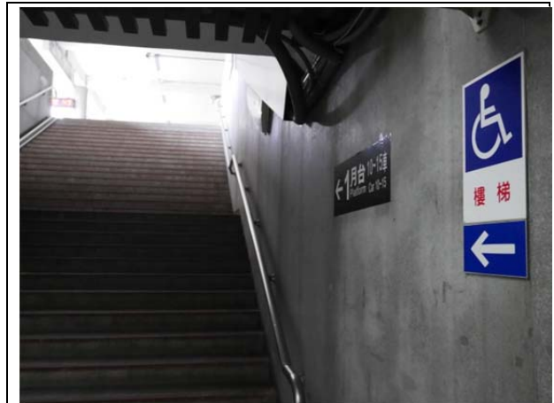
圖3-70無障礙圖例有誤，引導為無障礙路徑卻是階梯上樓處
