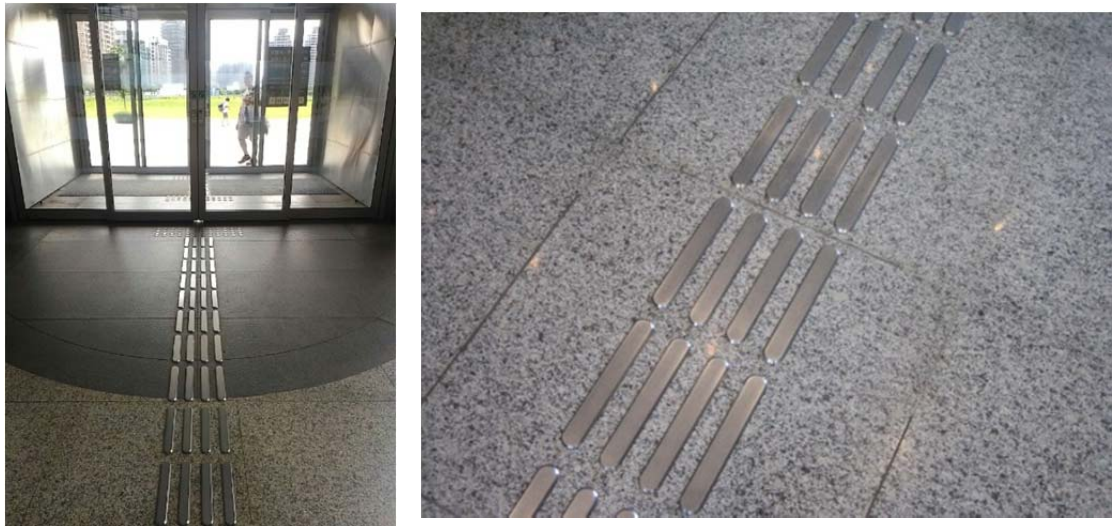
圖4-31 新竹高鐵站現行採用改良式導盲磚
