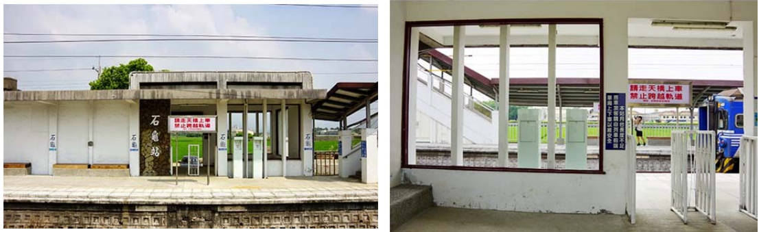
圖4-32無人車站應更注意緊急通報系統之建立
