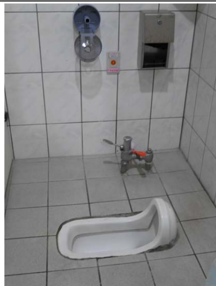
圖3-40 便器距離衛生紙架、服務鈴太遠且設置高度過高
