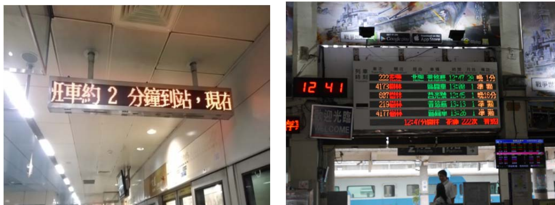
圖4-7LED 電子顯示系統，提供即時列車到站訊息
