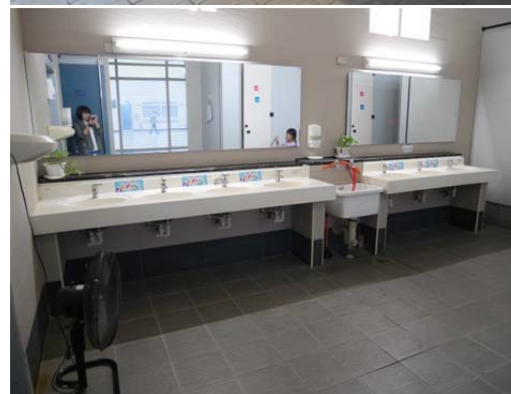
圖3-42 未依據旅客使用性質不同，設置不同高度之洗手台
