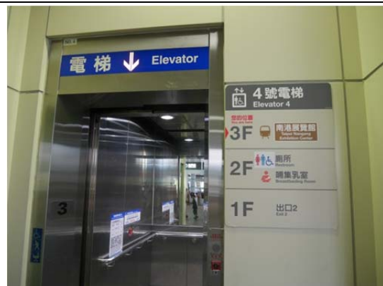
圖3-80電梯抵達樓層標示清楚
