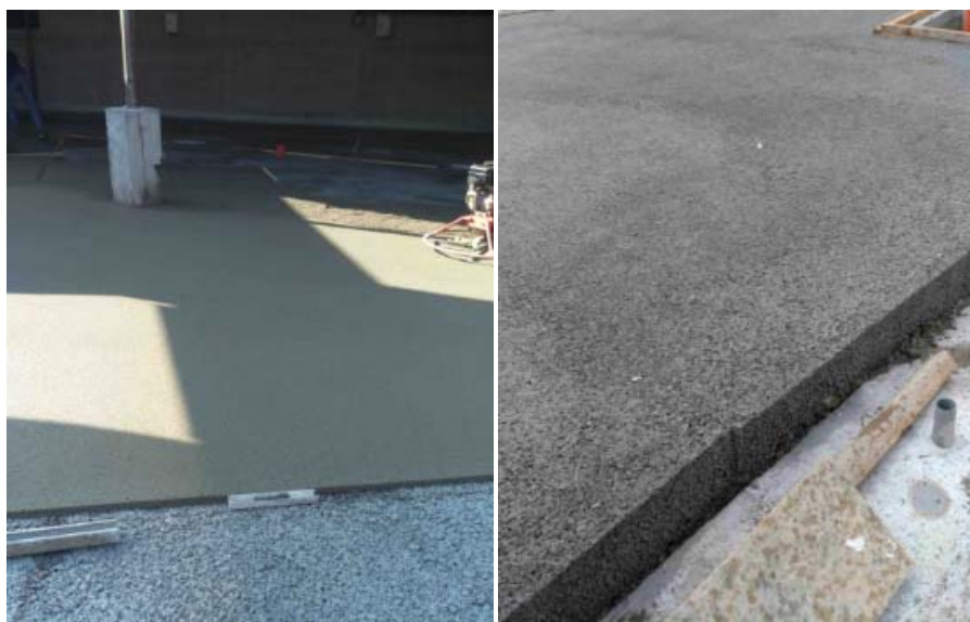
圖 4.3 現場澆置剛性透水鋪面
