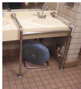
圖 3-65 供輪椅者使用之洗面盆設計
