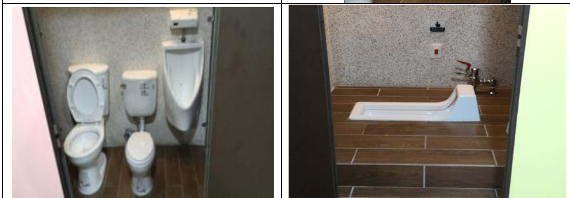
性別友善廁所內針對不同使用於不同廁間設置不同便器。
