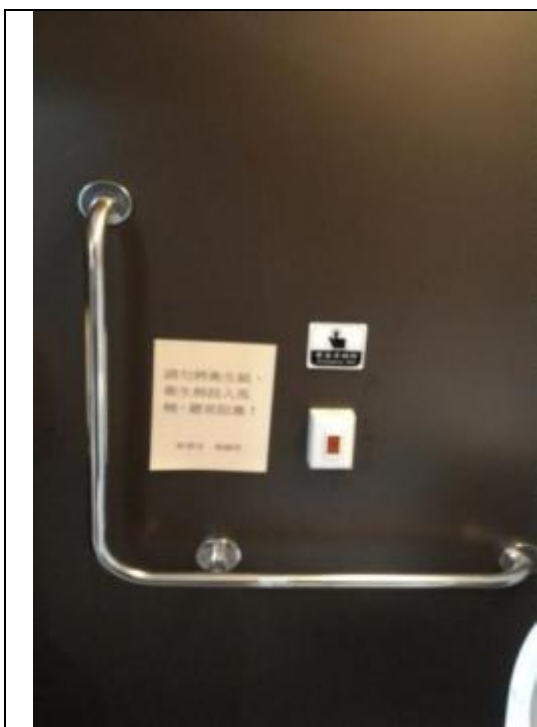
廁間設扶手及緊急求助裝置。
