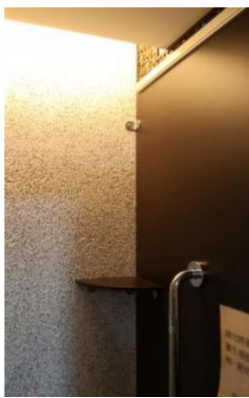
廁間內設置照明自動感光點滅裝置，以節省電源及如廁安全感。
