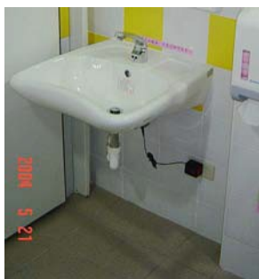
圖 3-65 供輪椅者使用之洗面盆設計
