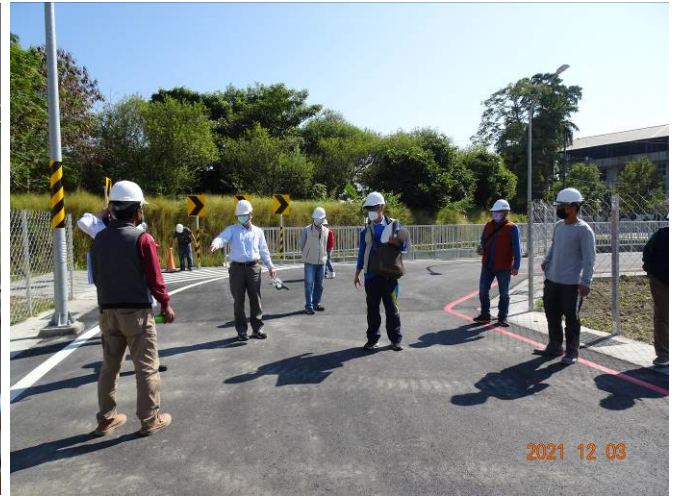
▶▶ 施工督導 (工區現場)
