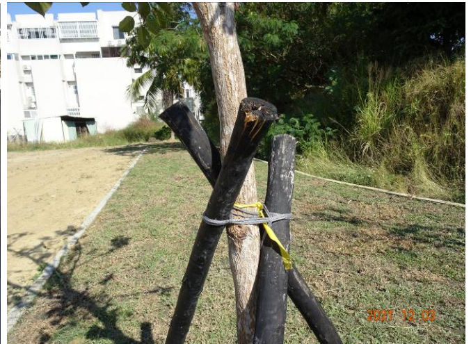
▶▶ 部分樹木支架端頭已裂開，支架固定不符施工規範規定
