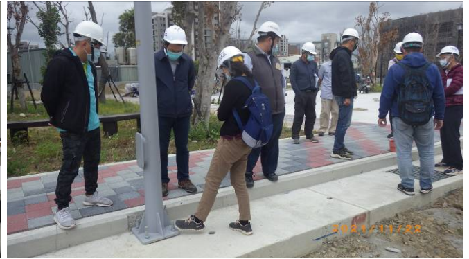
▶▶ 施工督導 (工區現場)
