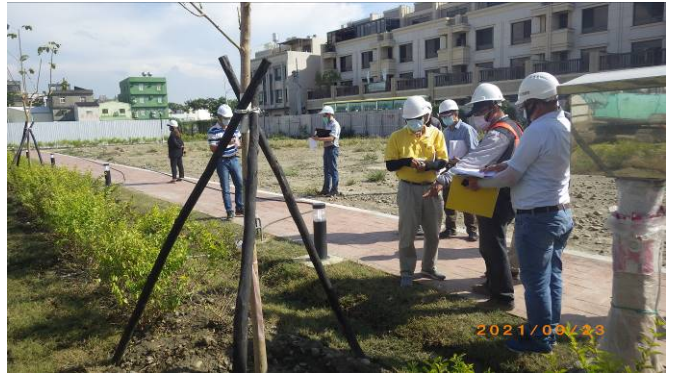
▶▶ 施工督導 (工區現場)
