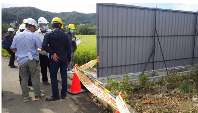
▶▶ 施工督導 (工區現場)
