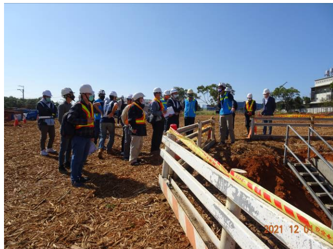
▶▶ 施工督導 (工區現場)
