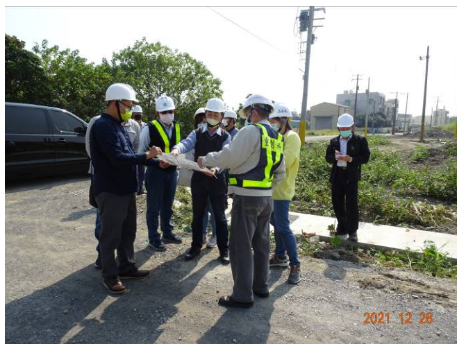
▶▶ 施工督導 (工區現場)
