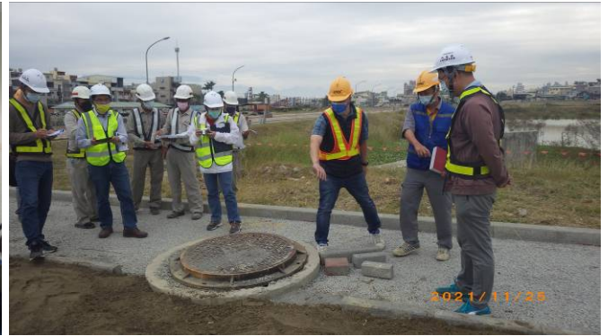
▶▶ 施工督導 (工區現場)
