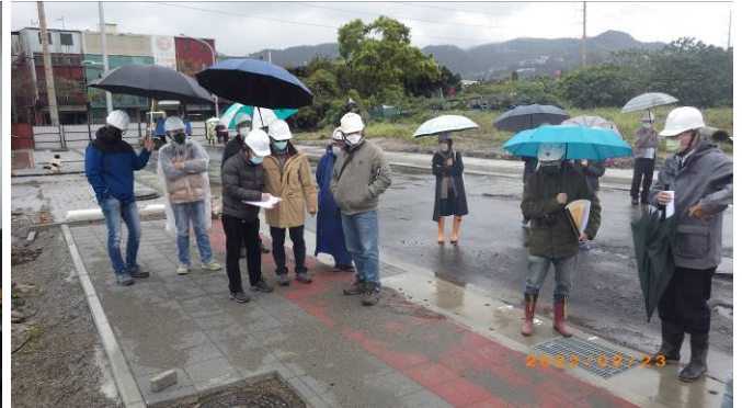
▶▶ 施工督導 (工區現場)
