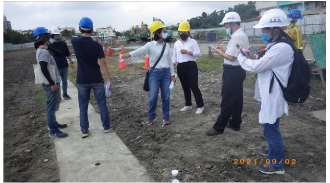
▶▶ 施工督導 (工區現場)
